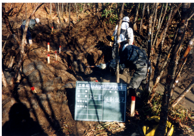
写真－動物 3－3 M1 池造成施工中の状況
