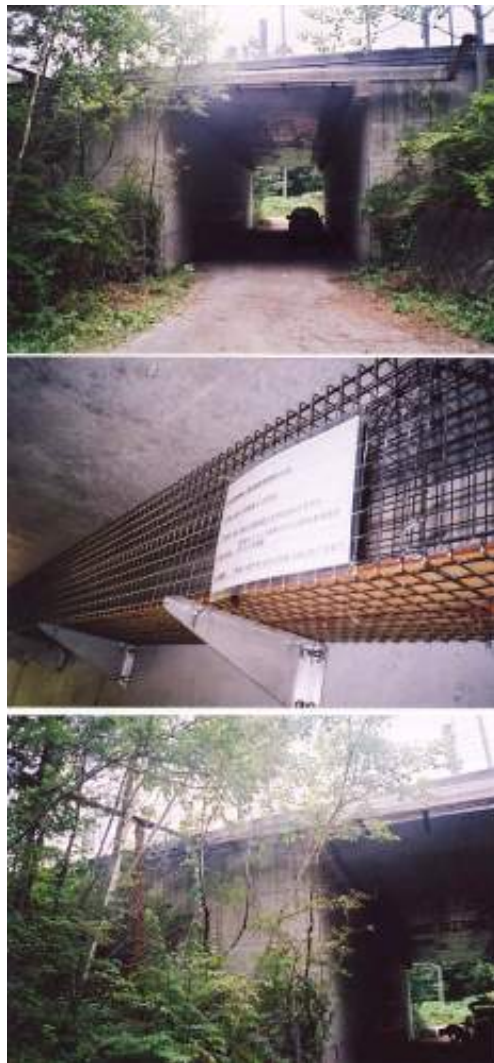
図一事例 15－1 リス橋の構造（左）および設置状況（右）
