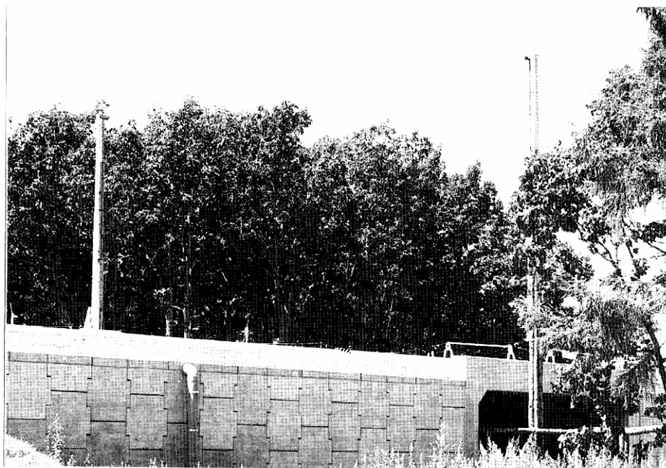
写真－事例 10－2 設置状況
