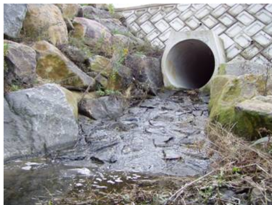
写真一事例 6-2 道路横断施設下流側 (調整池側)
