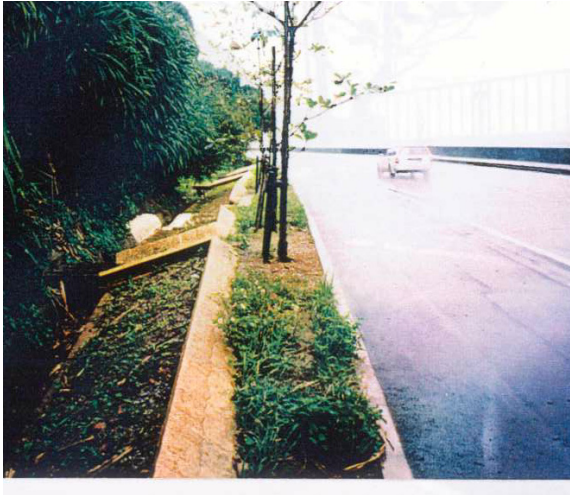
道路への進入防止のためのエコパネルを設置した 写真-事例 4-4 エコパネル設置状況
