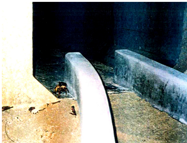
トンネル内へ確実に誘導するためにパネルを設置した。
