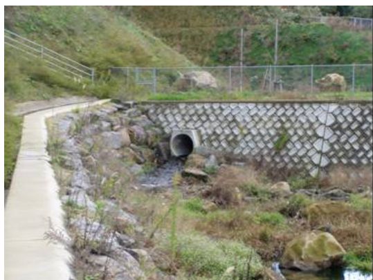
写真一事例 6-1 道路横断施設下流側 (調整池側)
