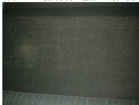
写真 1.1.8 被災事例 3 床版の被災
