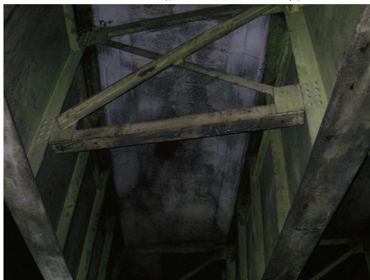
写真 1.1.5 被災事例 2 主桁・床版の被災
