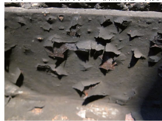
写真 1.1.12 被災事例 3 横桁塗膜のはがれ状況
