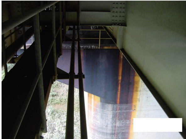
写真 1.1.1 被災事例 1 橋脚の被災
