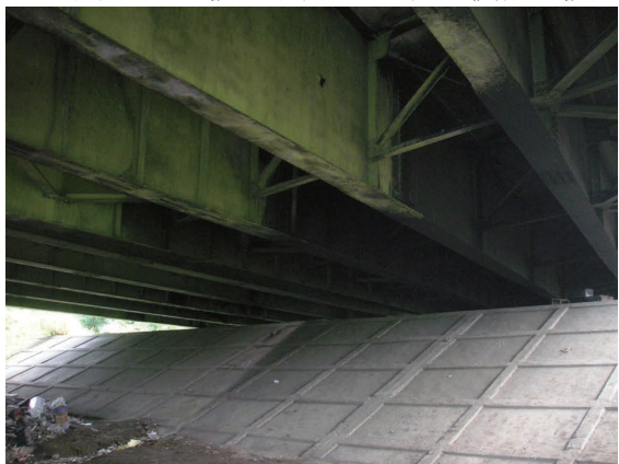
写真 1.1.4 被災事例 2 主桁の被災
