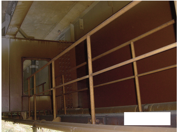
写真 1.1.2 被災事例 1 主桁・横桁の被災
