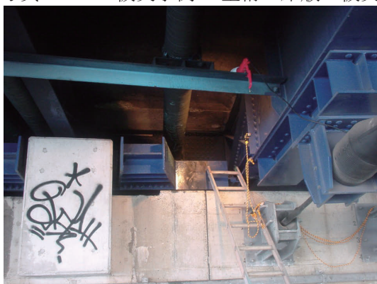
写真 1.1.7 被災事例 3 主桁・床版の被災
