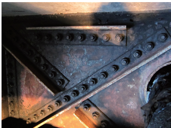
写真 1.1.9 被災事例 3 横桁の被災
