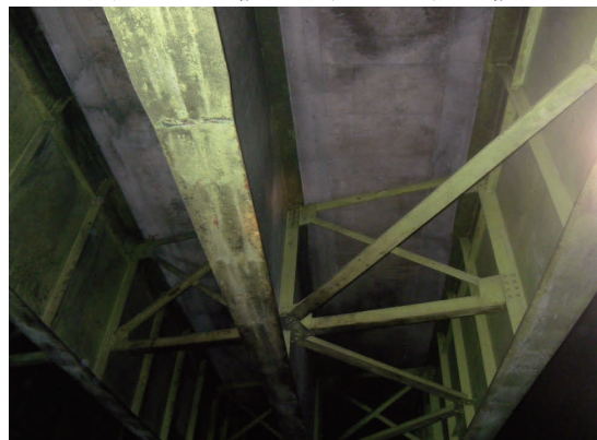
写真 1.1.6 被災事例 2 主桁・床版の被災
