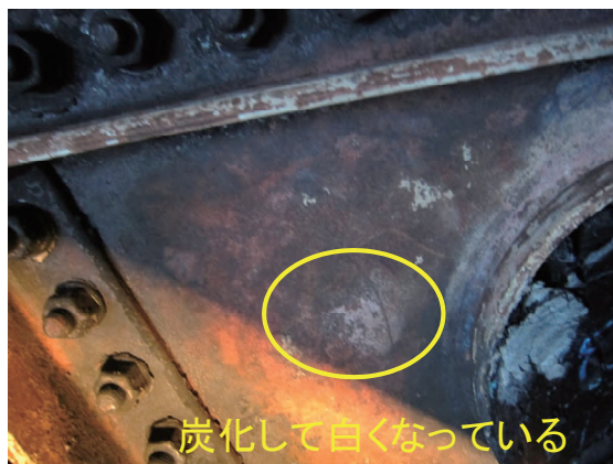
写真 1.1.10 被災事例 3 横桁炭化の状況
