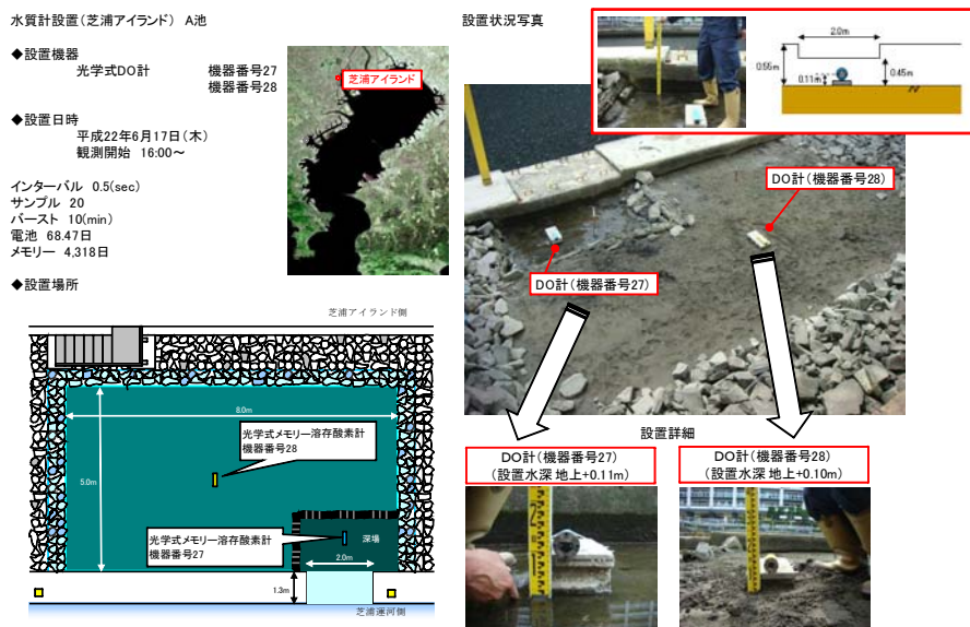
図-25 定点観測用水質計(光学式DO計)設置状況 (A池)
