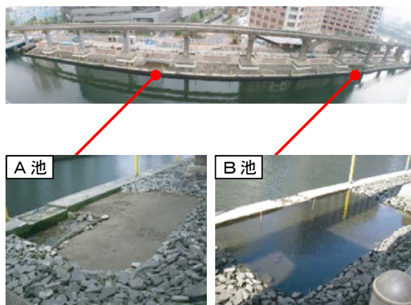
図-9 テラス護岸全景(上)とA池(下、左)、B池(下、右)
