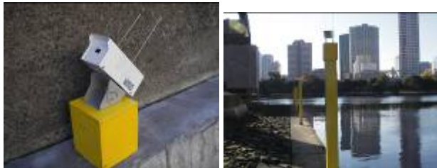
図-33 カメラ設置状況
