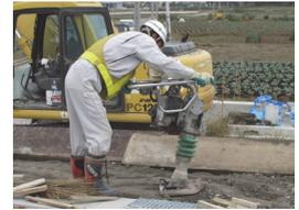
ランマの締固め状況
