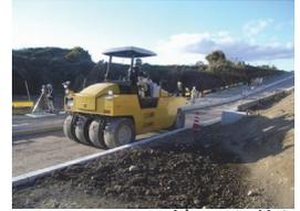
タイヤローラの締固め状況
