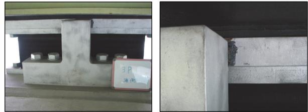
図-1 P3 橋脚上の支承の上フランジとサイドブロックの接触痕
