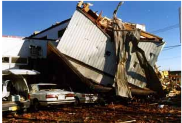
写真 6.2-2 茂原竜巻（1990）での被害 （茂原市消防署）
