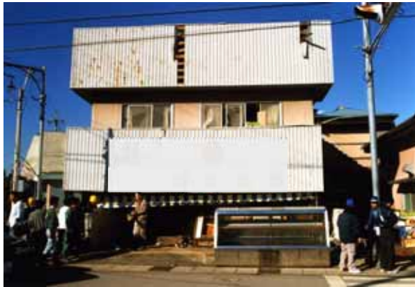
写真 6.2-5 茂原竜巻（1990）での店舗の上部構造の移動（茂原市消防署）
