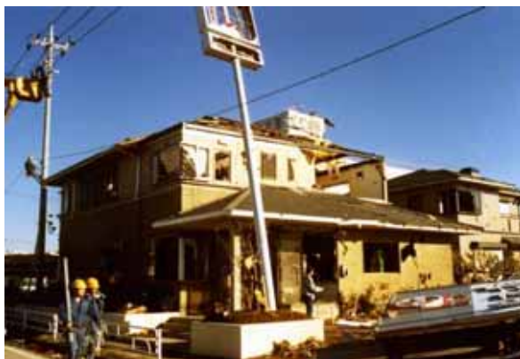
写真 6.2-7 茂原竜巻（1990）での軽量鉄骨造住宅の被害（茂原市消防署）
