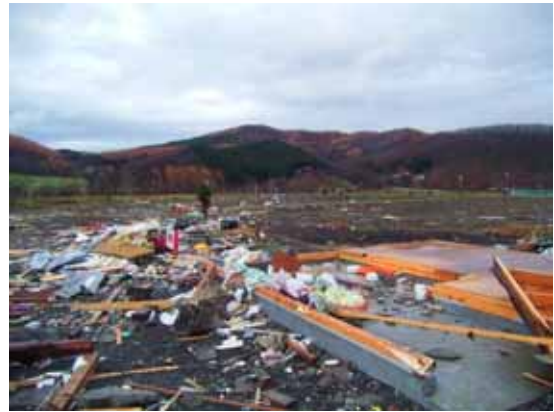
写真 6.2-6 佐呂間竜巻（2006）での店舗併用住宅の飛散（国土交通省北海道開発局）
