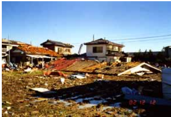
写真 6.2-3 茂原竜巻（1990）での縫製 工場屋根の飛散（茂原市消防署）
