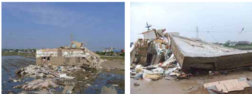
写真 5.3-1 転倒した木造建築物
