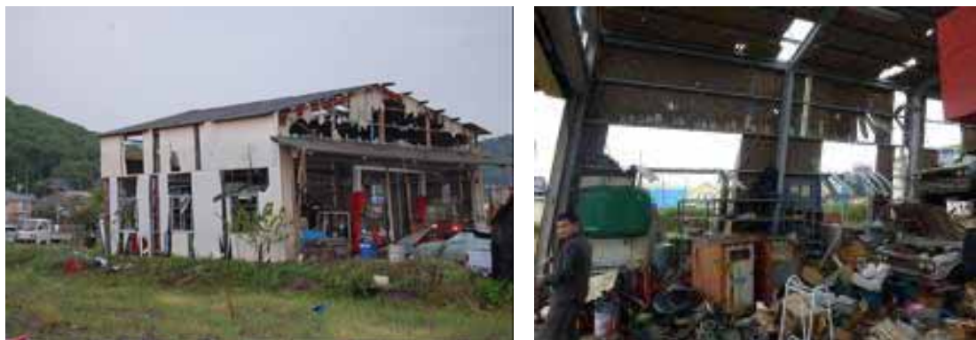
写真 5.6-1 傾斜した鉄骨造建築物
