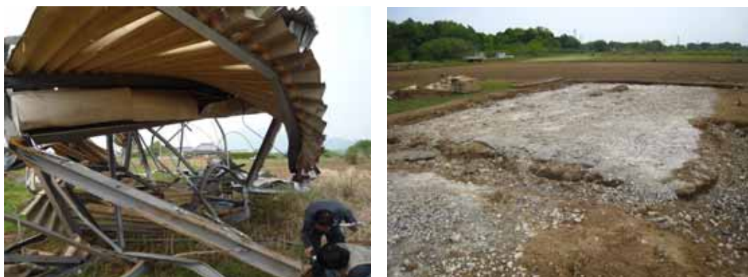
写真 5.5-1 崩壊した鉄骨造建築物
