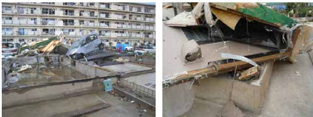
写真 5.4-1 上部構造が飛散した木造建築物
