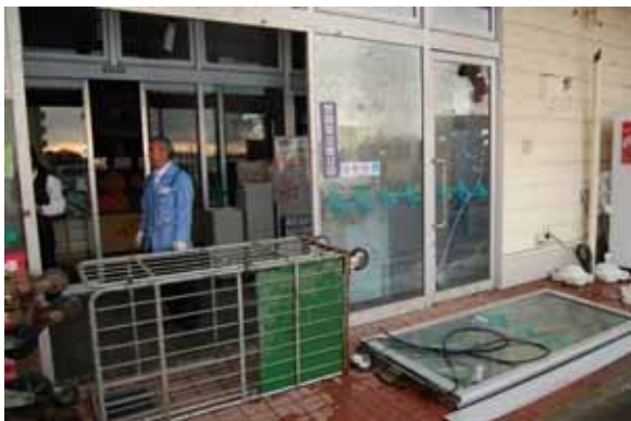
写真 3.4-33 建具の脱落
