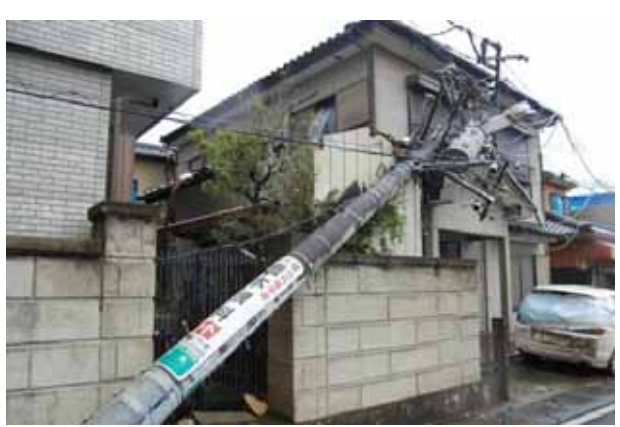
写真 3.5-8 電柱の折損・傾斜
