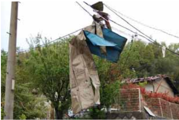
写真 3.4-5 電線等に引っ掛かった飛来物（鋼板製屋根材）
