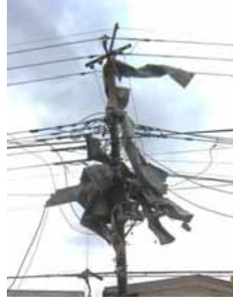
写真 3.4-5 電線等に引っ掛かった飛来物（鋼板製屋根材）
