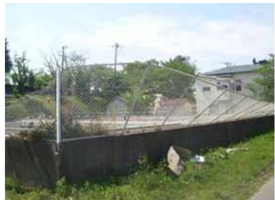
写真 3.5-10 フェンスの被害状況
