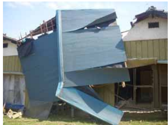
写真 3.4-7 飛来物（小屋組）の衝突
