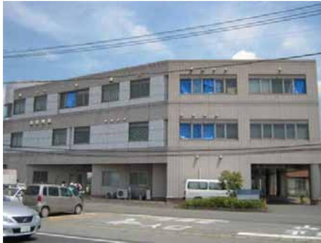
写真 3.3-4 鉄筋コンクリート造建築物 B
