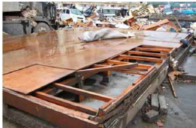
写真 3.1-14 写真 3.1-13 の1階床仕様
