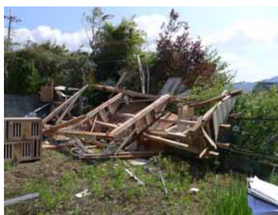
写真 3.1-27 倒壊した木造建築物
