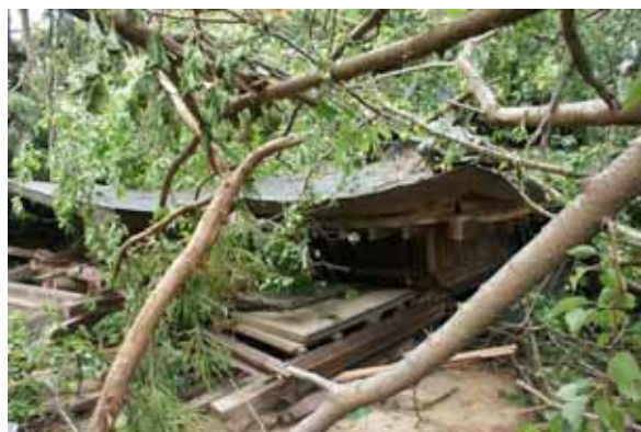
写真 3.5-18 倒木による社の倒壊
