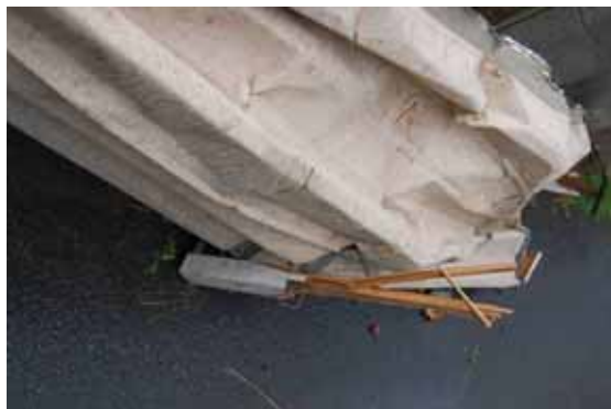
写真 3.4-8 飛散した折板屋根の状況
