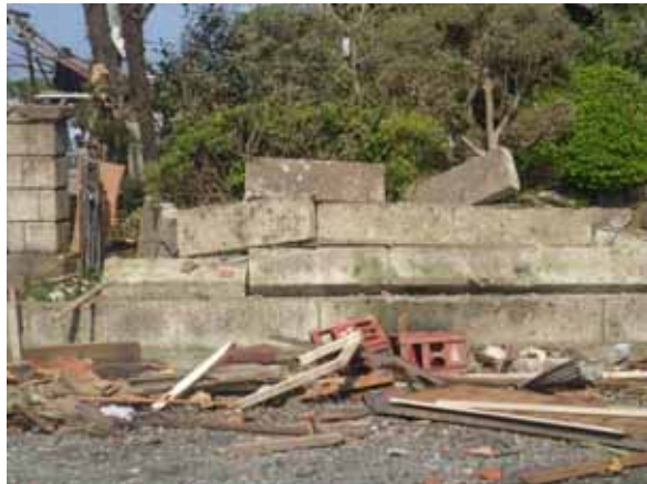
写真 3.5-3 石塀の倒壊
