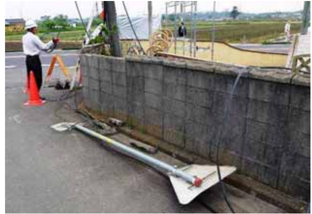
写真 3.5-6 道路標識の折損
