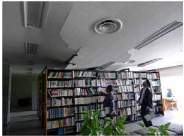
写真 3.4-39 天井材の被害
