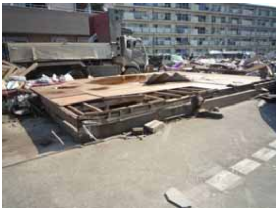
写真 3.1-13 土台を残し飛散した木造建築物
