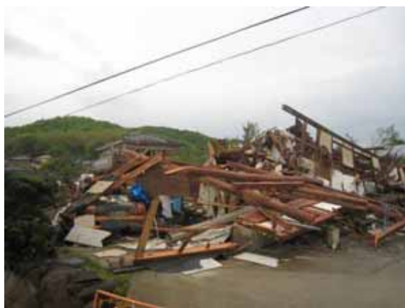
写真 3.1-26 倒壊した木造建築物
