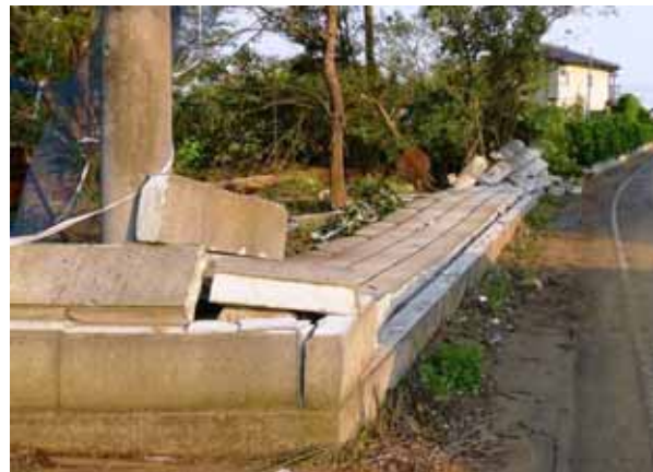
写真 3.5-4 石塀の倒壊
