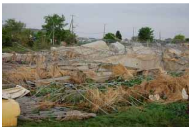
写真 3.5-9 パイプハウスの被害状況
