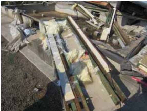
写真 3.1-11 写真 3.1-9 の飛散した部材
