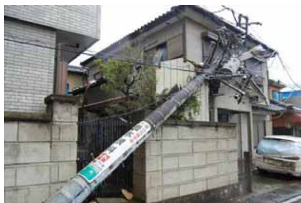
写真 3.5-8 電柱の折損・傾斜
