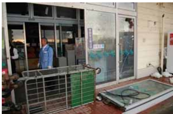
写真 3.4-33 建具の脱落
