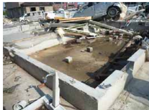
写真 4.2-4 上部構造の飛散
