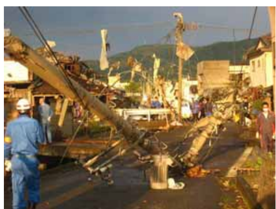
写真 3.5-7 電柱の折損・傾斜
