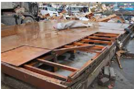
写真 4.2-3 上部構造の飛散
