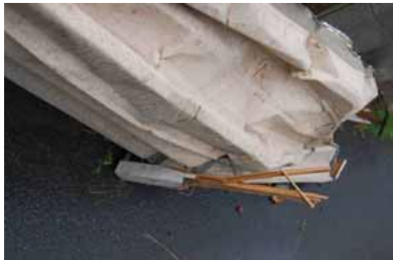
写真 3.4-8 飛散した折板屋根の状況
