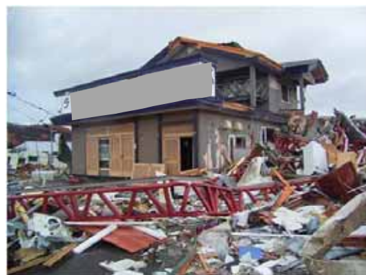
写真 4.1-2 佐呂間竜巻(2006)での飛散物の状況
