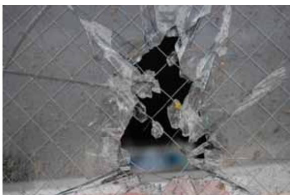
写真 3.4-36 ガラスへの飛来物の衝突痕
