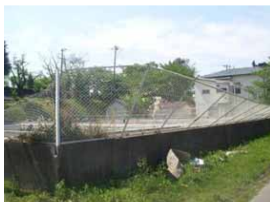
写真 3.5-10 フェンスの被害状況
