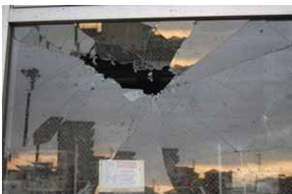
写真 3.4-35 ガラスへの飛来物の衝突痕
