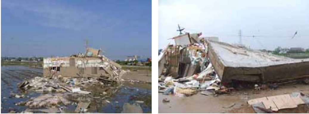
写真 5.3-1 転倒した木造建築物
