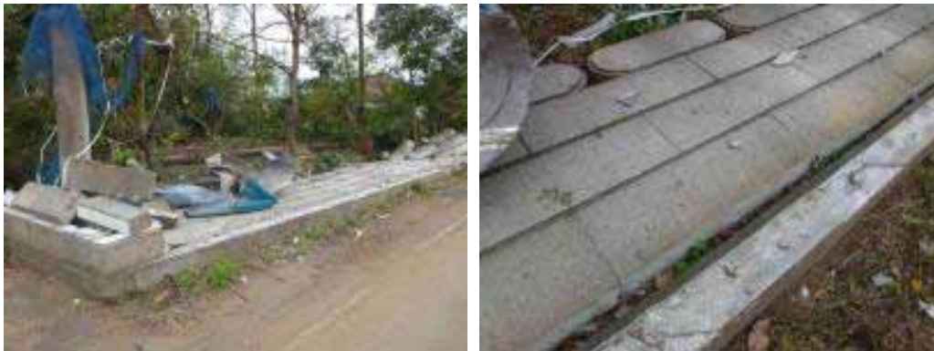
写真 5.7-1 転倒した石塀
