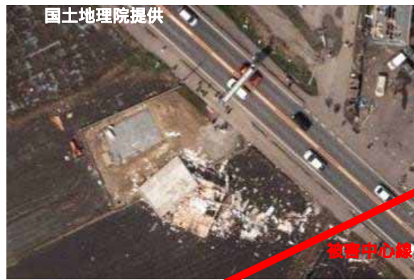
写真 3.1-8 写真 3.1-1 の被災後の航空写真
