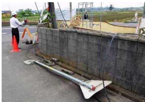
写真 3.5-6 道路標識の折損
