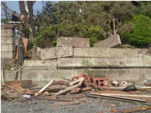
写真 3.5-3 石塀の倒壊
