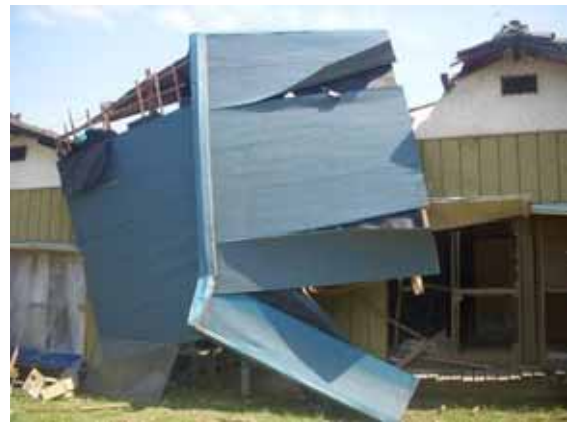
写真 3.4-7 飛来物（小屋組）の衝突
