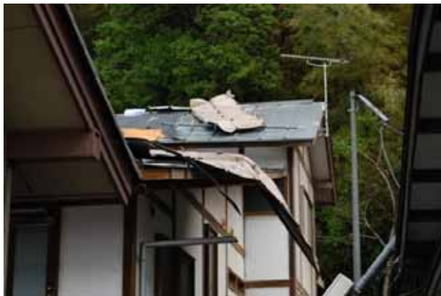
写真 3.4-6 飛来物（鋼板製屋根材）の衝突
