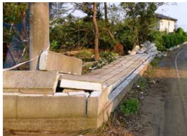
写真 3.5-4 石塀の倒壊
