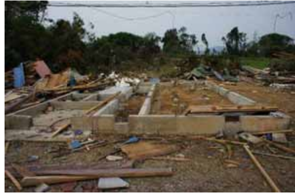
写真 3.1-18 写真 3.1-17 の基礎外観
