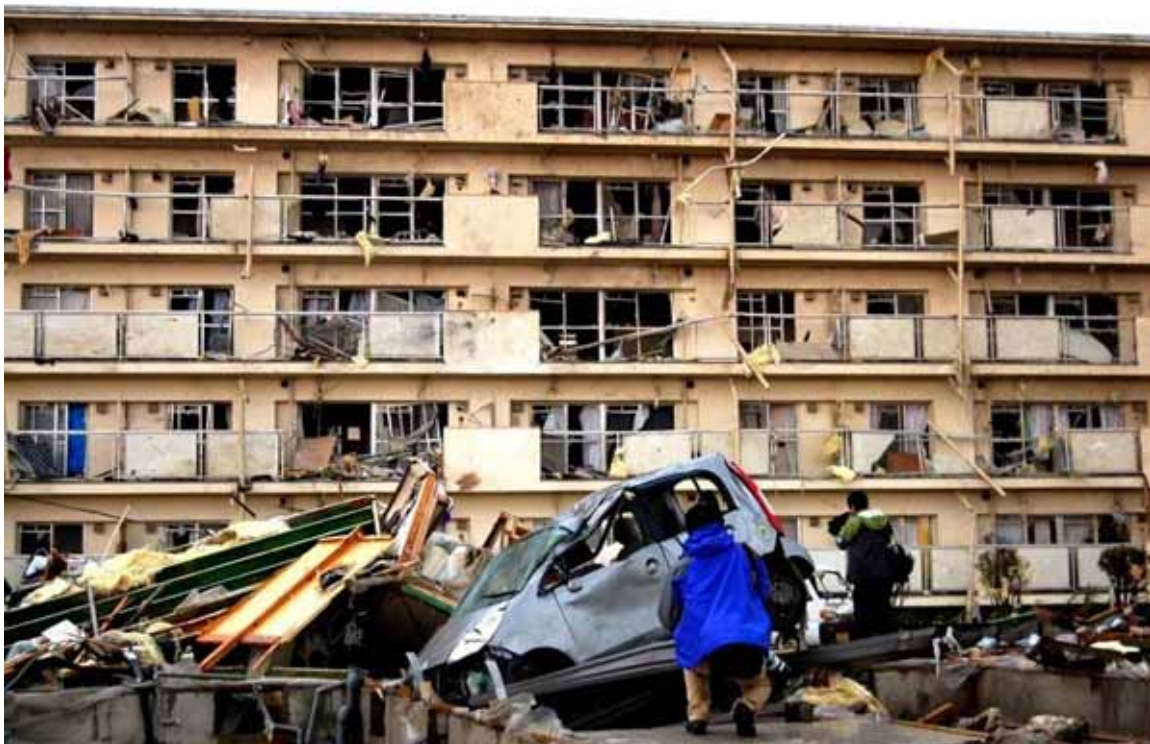
写真3.4-26 5階建て集合住宅南面の被害状況
