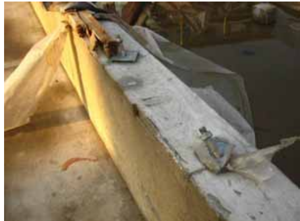
写真 3.1-12 写真 3.1-9 の残存する接合金物
