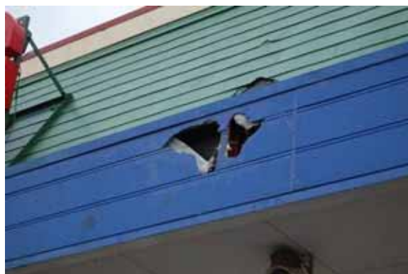
写真 3.4-34 エントランスでの飛来物の衝突痕
