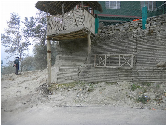
ブロック末端付近の民家土台の亀裂
