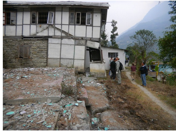
地盤伸縮計等の予定箇所
