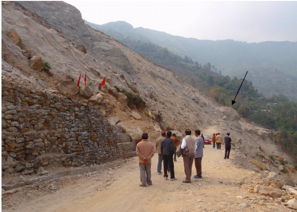
斜面崩落し巨礫が道に鎮座する
