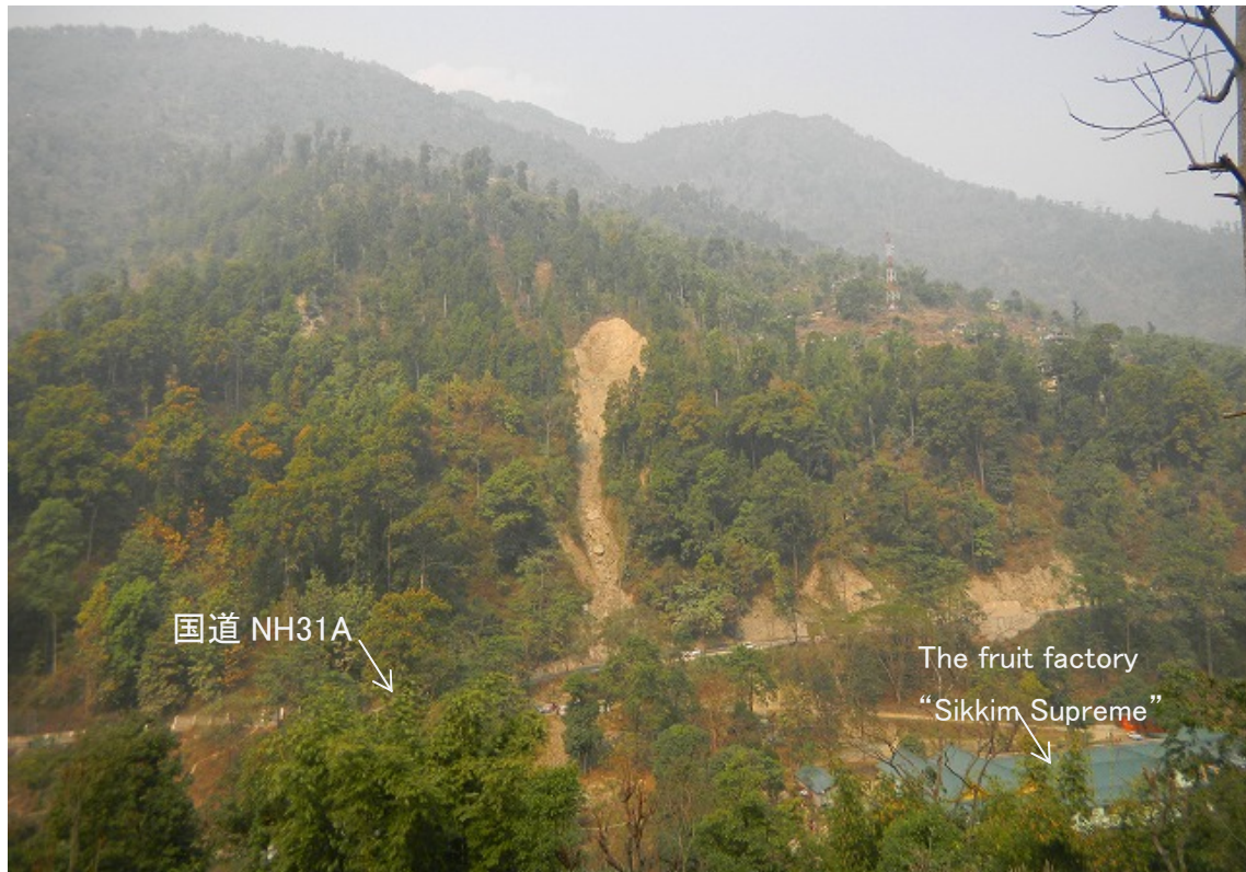
対岸から崩壊地の全景を望む
