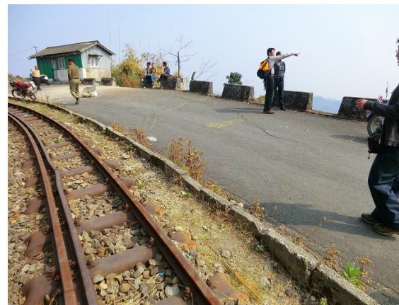
地すべり側部での道路上の亀裂と段差
