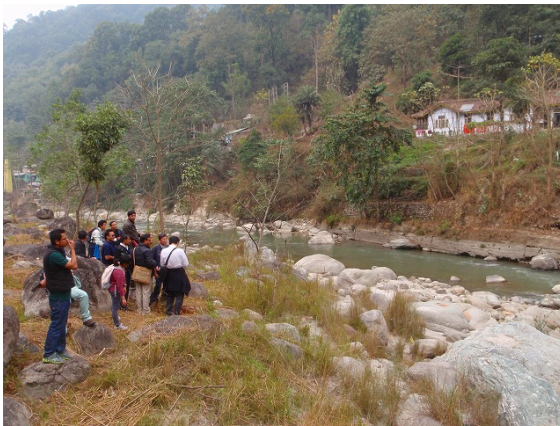
地すべりブロック脚部の水衝部
