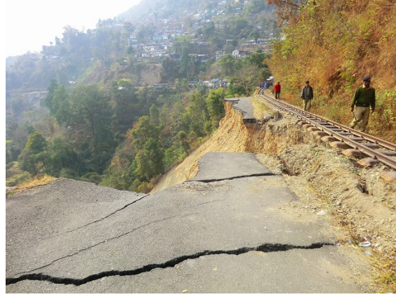
道路と鉄道の崩落、滑落崖
