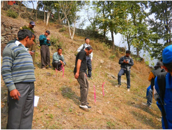
貫板設置の予定箇所
