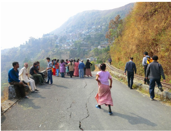
地すべり側部での道路上の亀裂と段差
