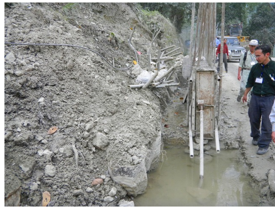
NH31 道路切土のネイリングとドラム缶パック
