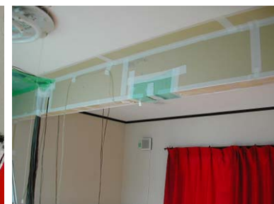
室内下がり壁と隙間状況
