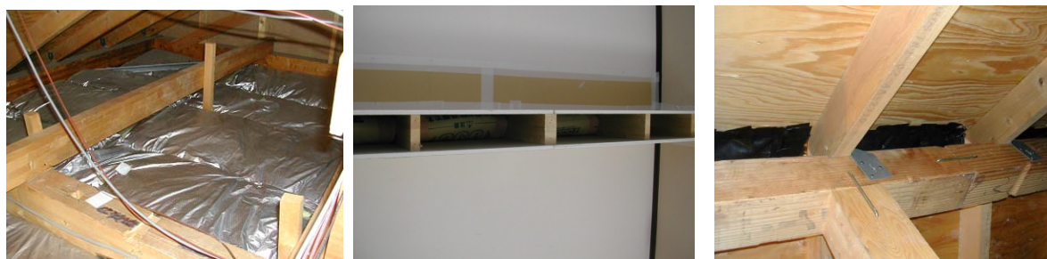
軒換気口は軒一軒換気の場合気密テープで塞ぐ
