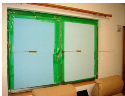
図 2.7.35 測定状況(B棟)
