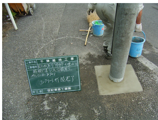
写真一解 11. 1 水切りコンクリートの施工事例
