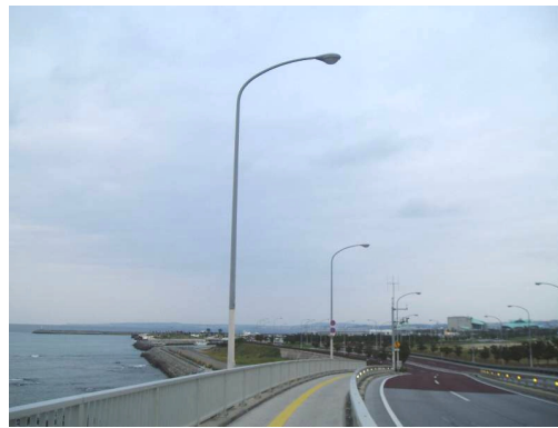
(b) 海岸付近に設置
