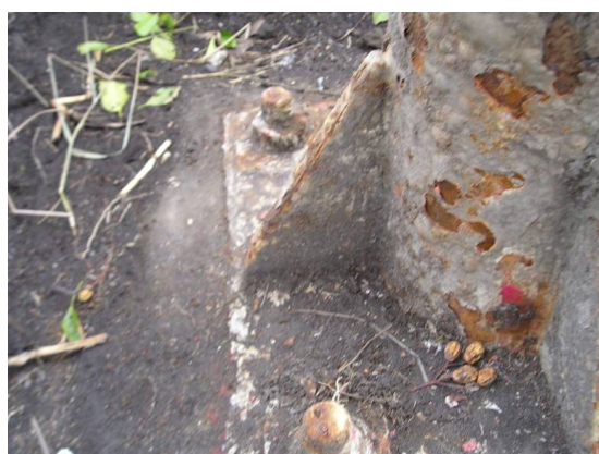
(a) 路面境界部が土砂で覆われている場合
