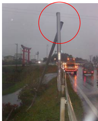
図一解 7. 3 支柱継手部の折損状況
