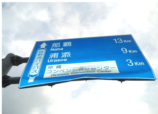
(a) 道路標識板の損傷状況
