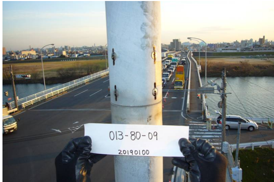
(a) 支柱継手部
