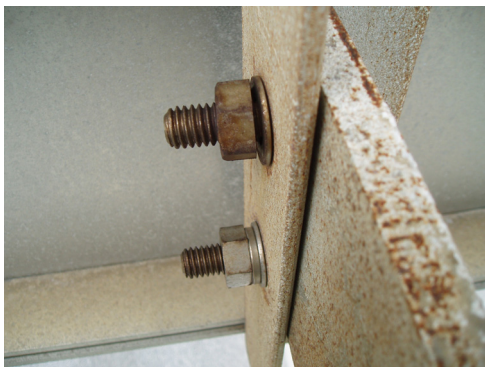
写真一解 7. 9 設置後 10 年以内の附属物の損傷事例
