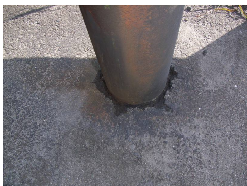
(腐食，路面付近での滞水)
