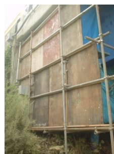
桁側面の防護 (A1 側)
