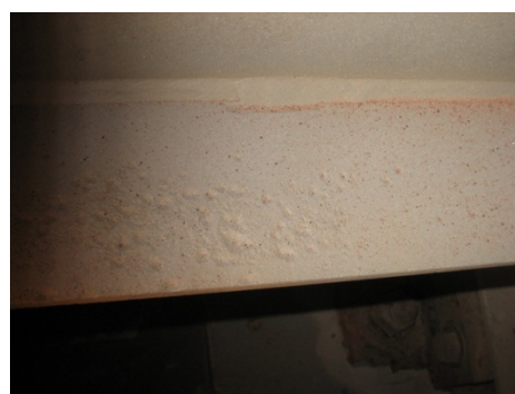
横桁裏面側の腐食跡
