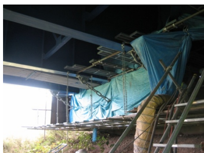
桁下側の防護 (A1 側)
