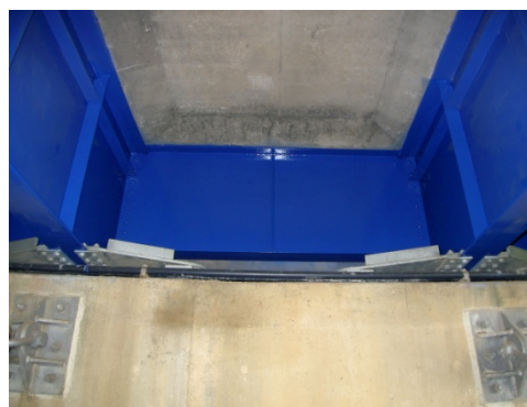
ブラスト時の旧塗膜養生 (A1側)
