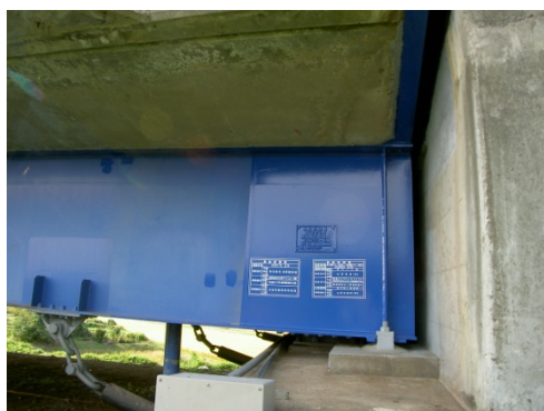
スプレー塗布時の旧塗膜養生 (A2側)
