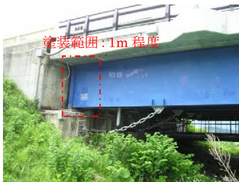
A1 側の桁端部 (桁側面)
