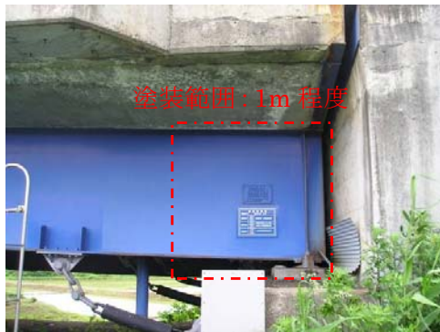
A2 側の桁端部 (桁側面)
