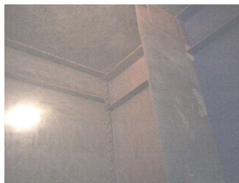
ブラスト時の旧塗膜養生 (A1側)
