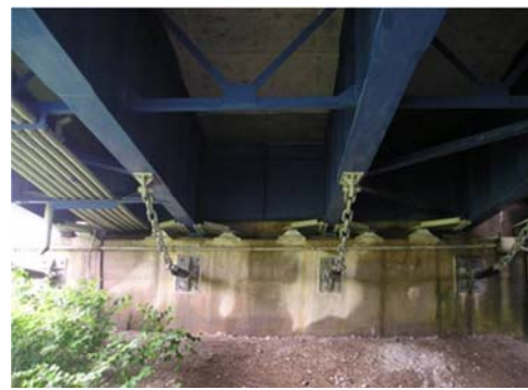
A1 側の桁端部 (桁間)
