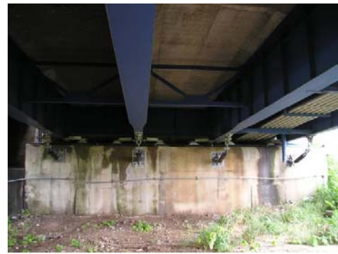
A2 側の桁端部 (桁間)
