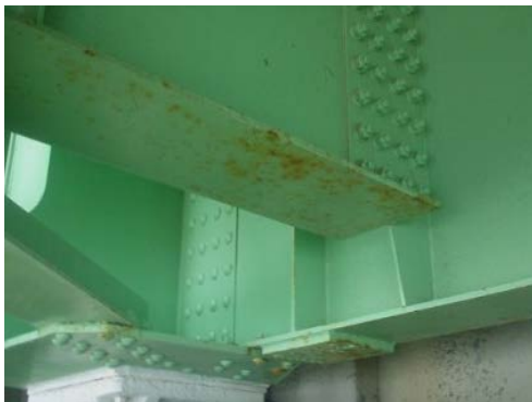
図-1.6 ３種ケレンによる塗替 (Rc-Ⅲ，約１年４ヶ月経過)
