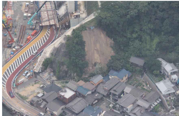
呉市音戸町坪井一丁目, がけ崩れ
