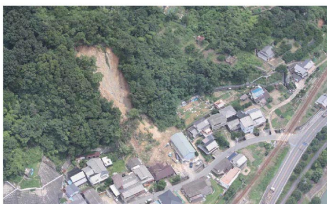
呉市安浦町白須, がけ崩れ
