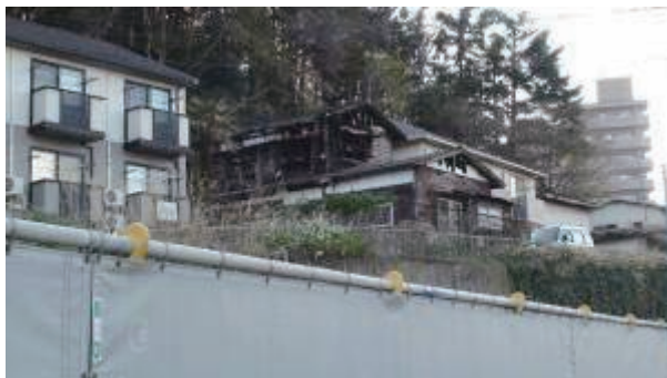
写真 7.2-7 仙台市太白区の住宅火災
