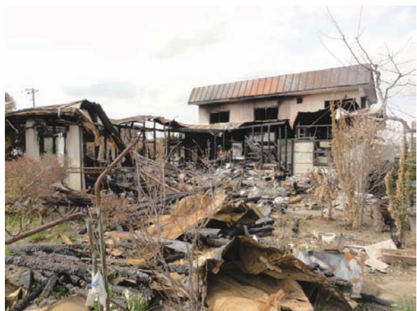
写真 7.2-5 奥州市水沢区小石田の火災
