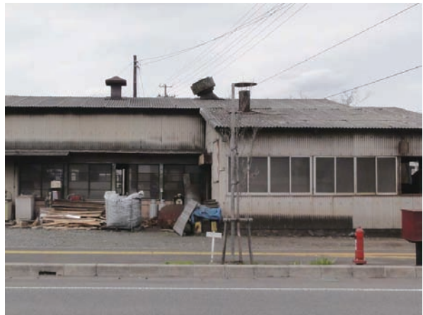
写真 7.2-6 奥州市水沢区羽田町の火災
