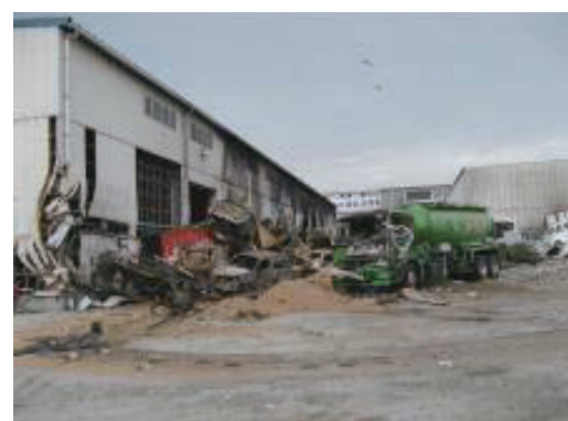
写真 7.3-12 仙台塩釜港北側の駐車場 1 の火災
