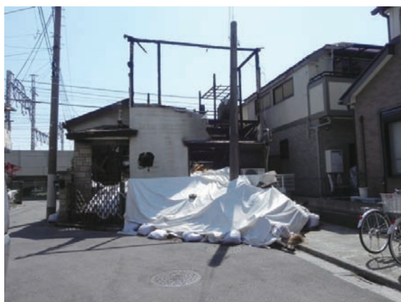
写真 7.2-22 火元建物外観（西側）
