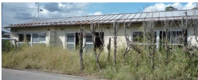
写真 D-4.1 岩沼市林住宅の外観 (メゾネット)
