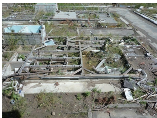
写真 D-2.6 流失した住戸の基礎と土台
