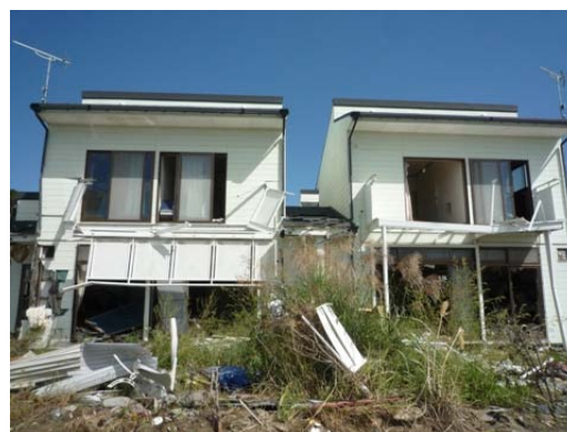
写真 D-2.7 大きく損傷し、残存した住戸
