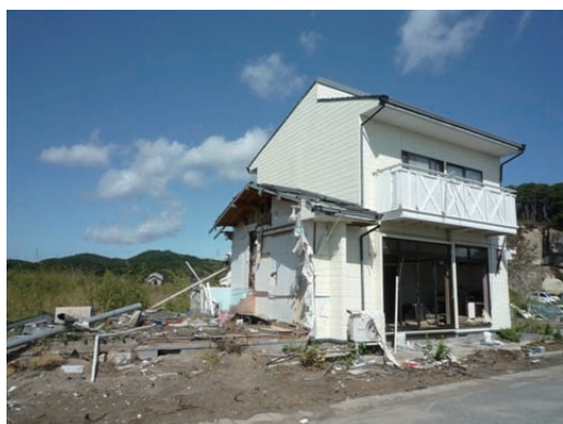
写真 D-2.8 一方の住戸が流失し、1つの住戸が残存した建物
