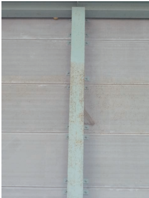
写真 D-2.3 屋内運動施設内側の浸水痕
