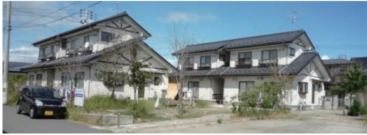
写真 D-3.1 鳴瀬中央第二住宅
