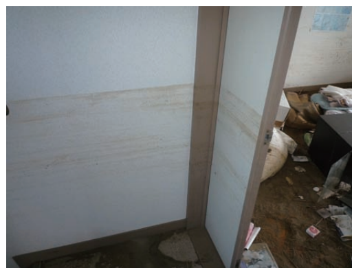
写真 D-2.9 2階内壁に残る浸水痕
