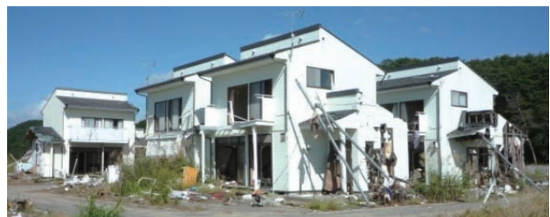
写真 D-2.5 東松島市州崎住宅
