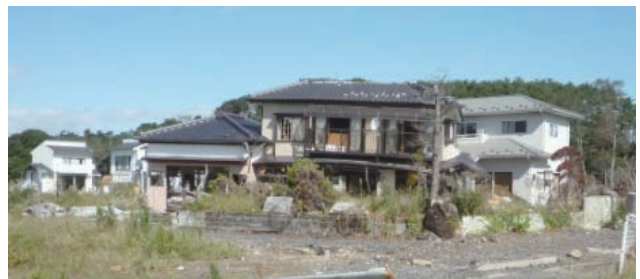
写真 D-2.4 大きく移動した木造家屋
