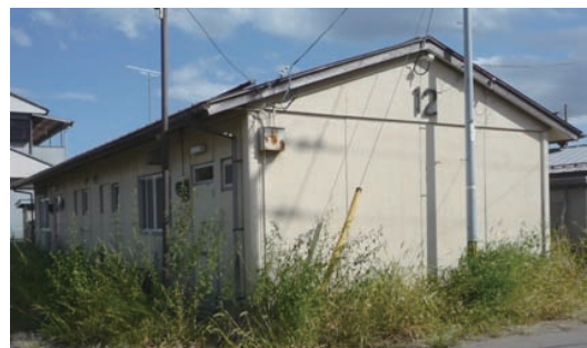
写真 D-4.2 外壁に残る浸水痕
