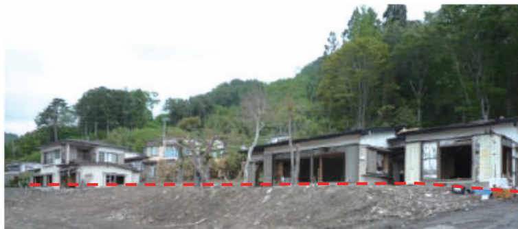
写真 6.4.2-3 写真 6.4.2-1 の住宅地の標高が写真 6.4.2-2 よりも高い場所に建つ建物。 (赤破線よりも標高が低い場所に建つ建物はほぼ流失)
