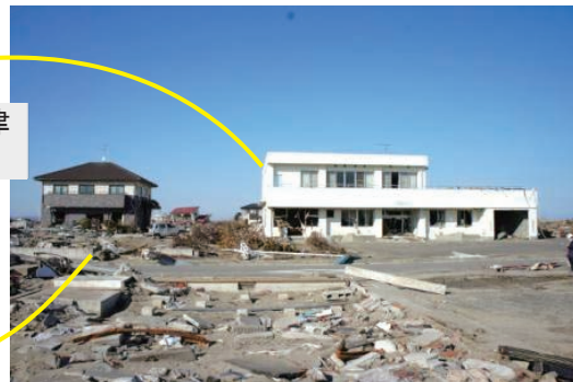
写真 6. 4. 1-4 入射方向に浸水深約 6m の低層 RC 建築物があつて、残存した木造住宅
