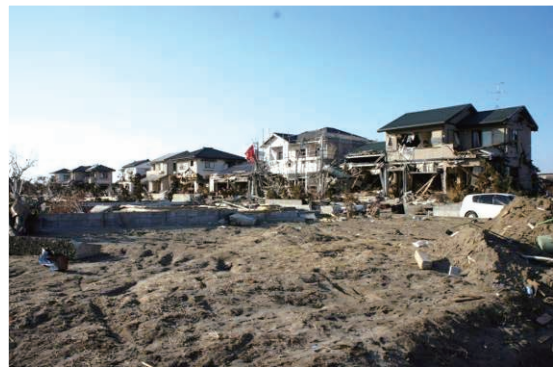
写真 6. 4. 1-5 入射方向先頭に鉄骨造住宅があって列状に残存した木造等住宅群（仙台市若林区）
