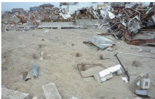
写真 6. 4. 1-13 べた基礎ごと建設地から移動し残存した例（右は当初位置に残る鋼管杭）
