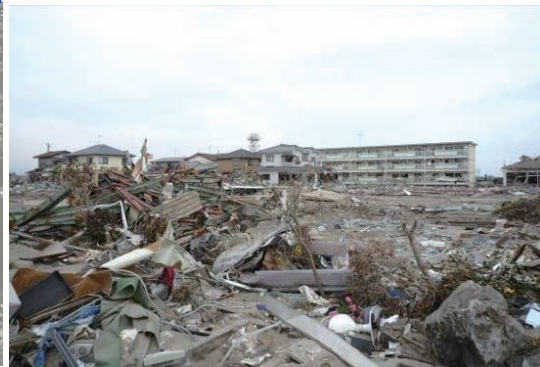
写真 6. 4. 1-3 津波の入射方向に建つ建築物により津波波力が軽減し、残存したと考えられる例 (名取市関上地区)
