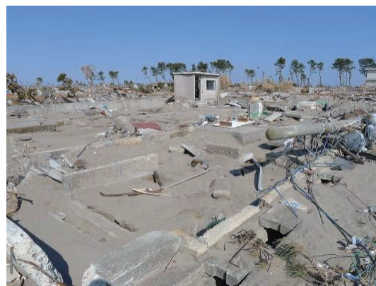
写真 6. 4. 1-17 上部構造と土台も流失した例
