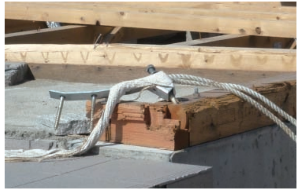
写真 6. 4. 1-21 ホールドダウン金物が破損した例
