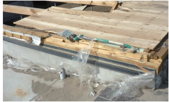
写真 6. 4. 1-19 床板も残存した例
