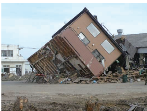
写真 6. 4. 1-14 転倒した木造建築物
