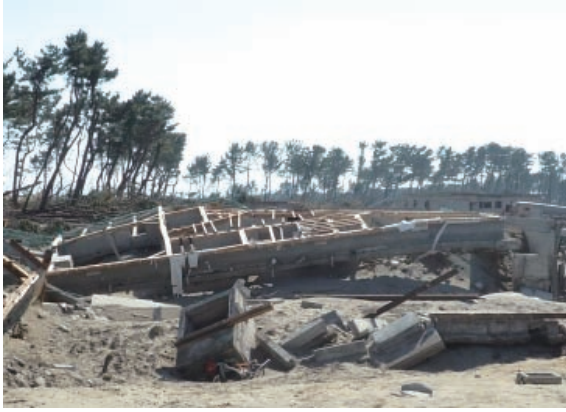
写真 6. 4. 1-18 基礎が流失した例
