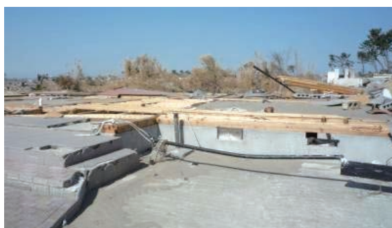
写真 6. 4. 1-16 上部構造が流失し土台が残った例
