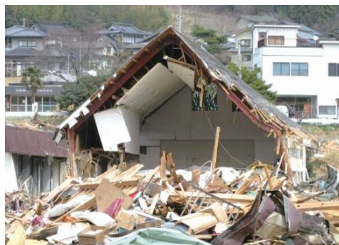
写真 6. 3. 1-10 傾斜した山形ラーメン架構
