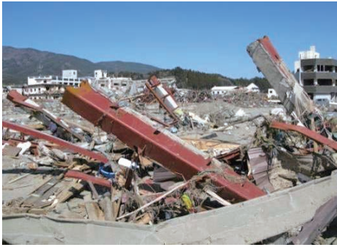
写真 6.3.1-3 1階柱の残存
