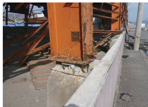
写真 6. 3. 1-14 柱脚部の移動（コンクリート塊や道路の舗装アスファルト等の漂流物によって考えられる）
