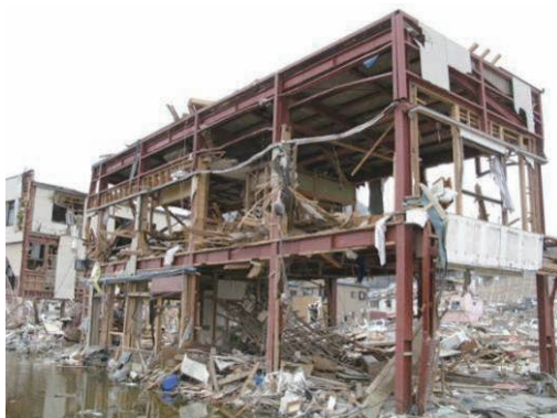
写真 6. 3. 1-11 残存するS造建築物
