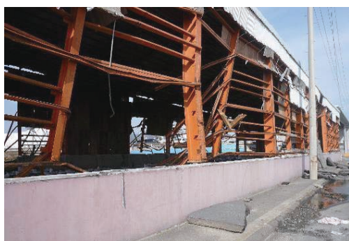
写真 6. 3. 1-13 柱の変形
