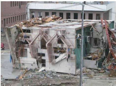
写真 6.3.1-5 3階建てS造の転倒
