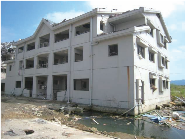
写真 6.2.7-1 建築物Fの全景 (図 6.2.7-1 の3棟のうち中央の1棟を北西側より臨む)
