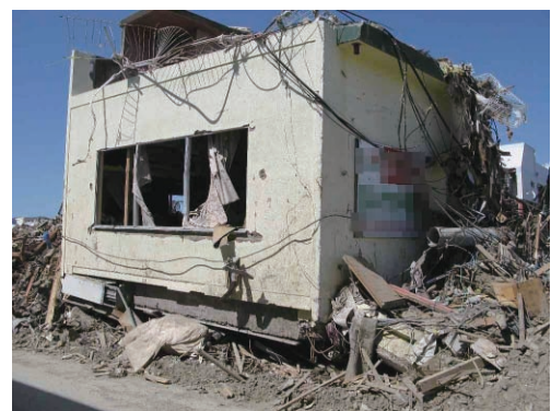
写真 6.2.1-2 2階建て建築物の層崩壊
