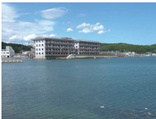
写真 6. 2. 2-1 被災後の建物状況 (南側)
