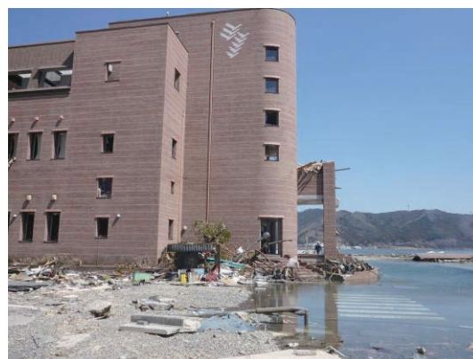
写真 6.2.4-2 建築物周囲の地盤沈降
