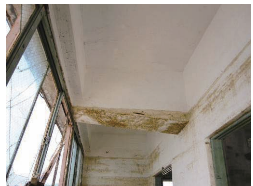
写真 6.2.1-6 建物内部の水の汚れの痕跡
