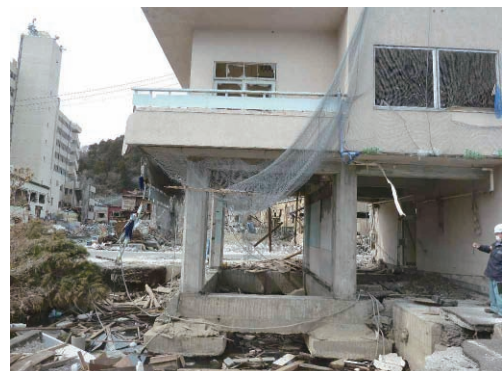
写真 6.2.1-9 洗掘による基礎の露出
