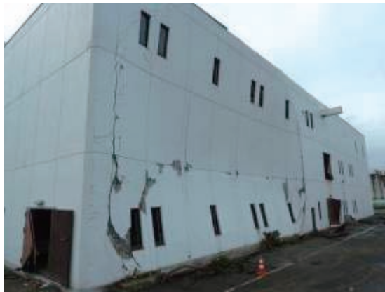
写真 6.2.5-1 耐震壁の面外変形
