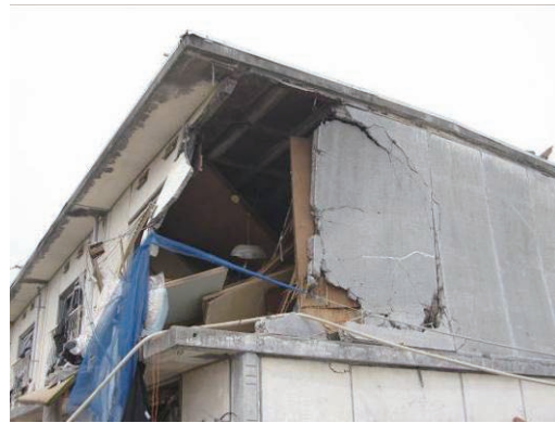
写真 6.2.6-2 2階妻壁の損傷
