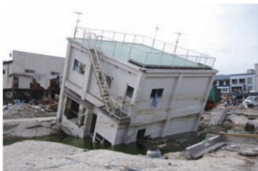
写真 6.2.1-10 洗掘による2階建て建築物の傾斜
