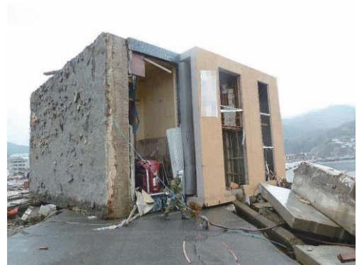
写真 6.2.1-4 3階建て直接基礎 建築物の転倒
