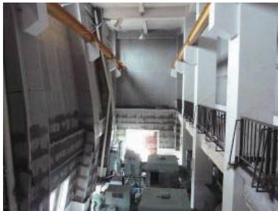
写真 6.2.5-3 建築物内部の浸水痕跡
