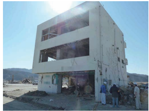
写真 6.2.1-3 残存する3階建て建築物
