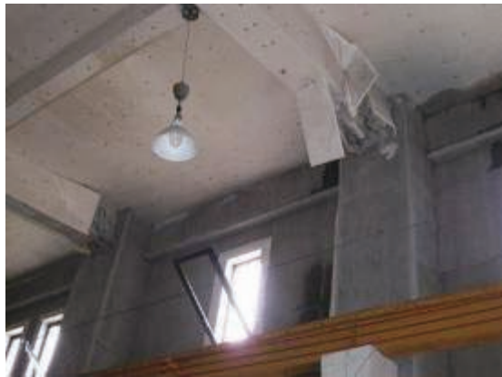
写真 6.2.5-2 屋上階梁下端の損傷
