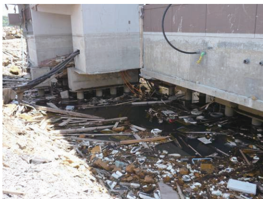
写真 6. 2. 2-5 基礎の洗掘 (中央部)
