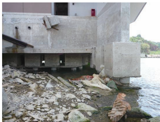
写真 6. 2. 2-6 基礎の洗掘 (妻側)
