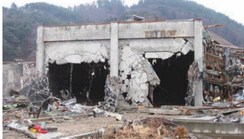
写真 6.2.1-12 非構造壁の面外破壊
