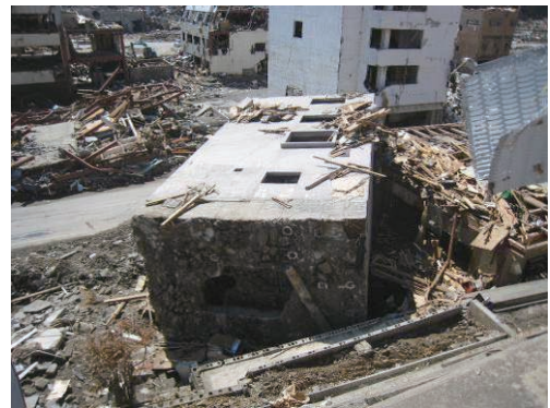
写真 6.2.1-5 4階建て杭基礎建築物の転倒
