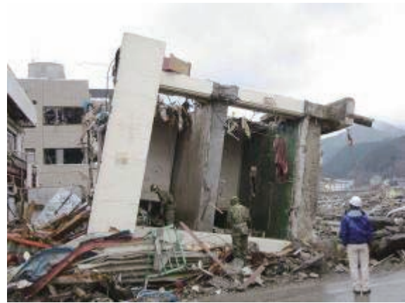
写真 6.2.3-2 建築物 西側立面
