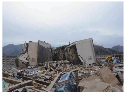
写真 6.2.1-8 CB造集合住宅の転倒
