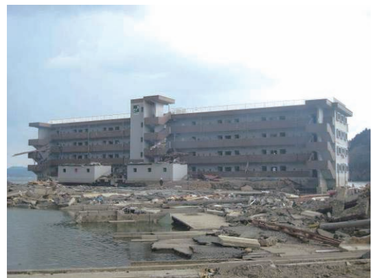
写真 6. 2. 2-2 被災後の建物状況 (北側)
