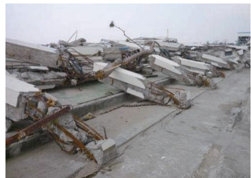
写真 6.2.1-1 2階建て建築物の倒壊
