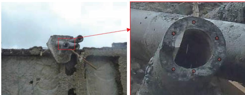
写真 6. 2. 3-3 建築物杭断面図
