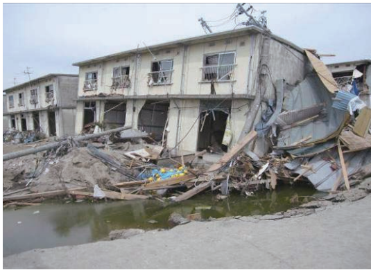
写真 6.2.6-1 周辺地盤の洗掘による傾斜
