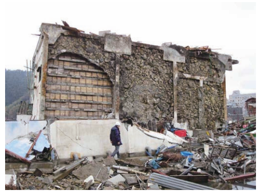
写真 6.2.1-7 塀を乗り越えた2階建て建築物
