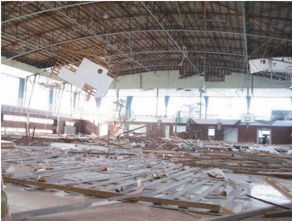
写真 5.7-1 木下地天井の脱落被害
