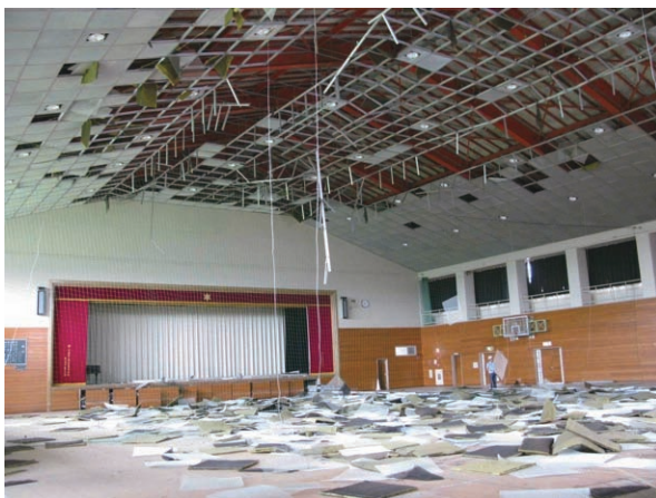
写真 5.7-3 天井板・下地材が脱落した被害
