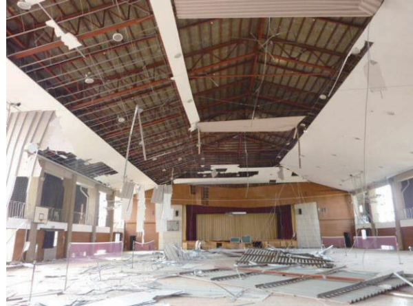
写真 5.7-2 在来工法による天井の脱落被害
