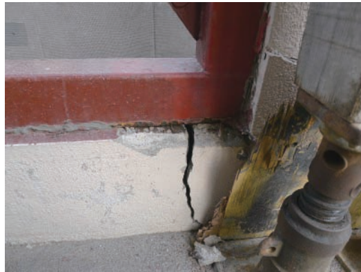
写真 5. 4. 2-26 基礎の亀裂
