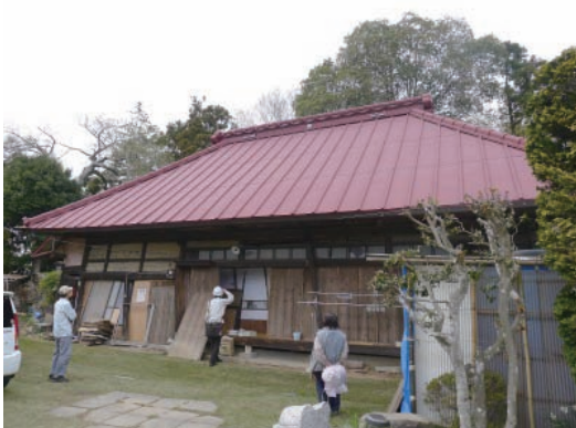
写真 5. 4. 2-15 調査建物の外観
