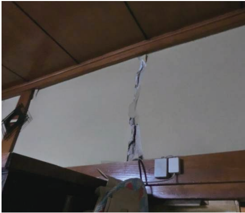
写真 5. 4. 2-49 住居部分 1 階居間土壁の損傷
