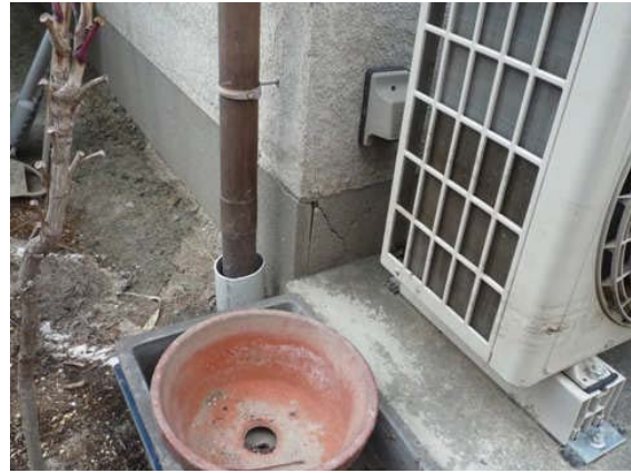
写真 5. 4. 2-54 基礎の亀裂
