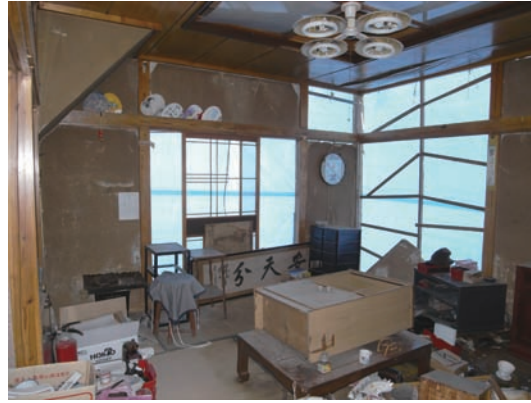
写真 5. 4. 2-28 内部の様子（内壁の損傷）
