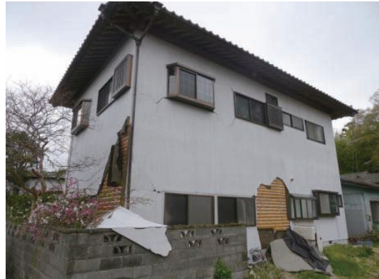
写真 5.4.2-12 モルタル外壁の脱落
