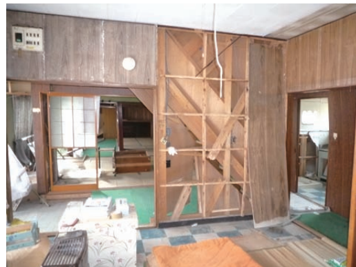
写真 5. 4. 2-22 内観と座屈した筋かい
