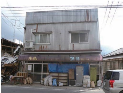
写真 5. 4. 2-43 建物の外観 (1 階傾斜)
