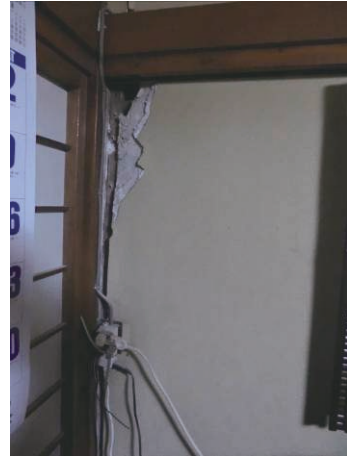
写真 5. 4. 2-48 住居部分 1 階居間土壁の損傷
