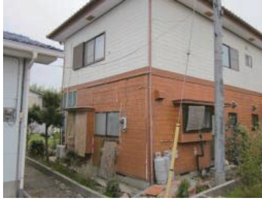
写真 5. 4. 2-20 外観－北東角／外壁補修箇所
