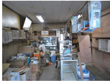
写真 5. 4. 2-44 内観 (1 階店舗部分の傾斜)
