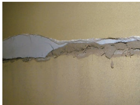
写真 5. 4. 2-2 土塗り壁等の剥落
