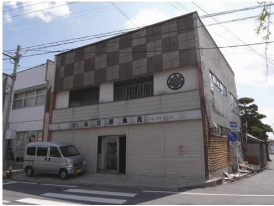
写真 5. 4. 2-31 外観（モルタル外壁の落下）
