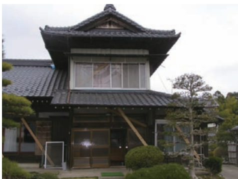
写真 5. 4. 2-1 外観と仮筋かい補強
