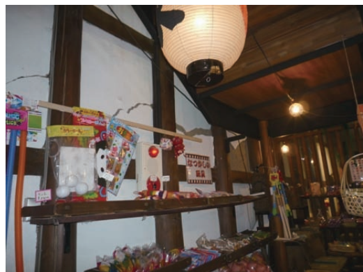
写真 5. 4. 2-36 1階土壁の亀裂と剥落
