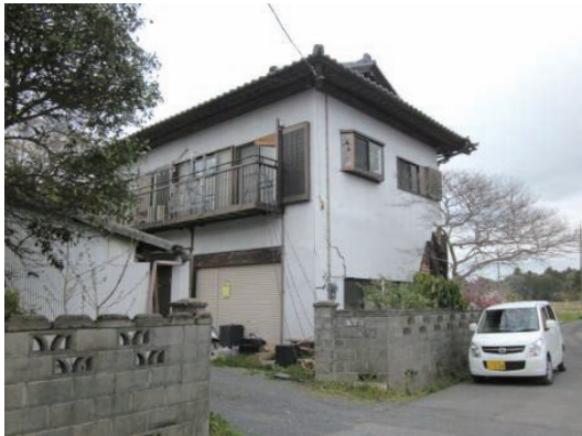
写真 5.4.2-11 建物外観、写真右側ガレージが倉庫
