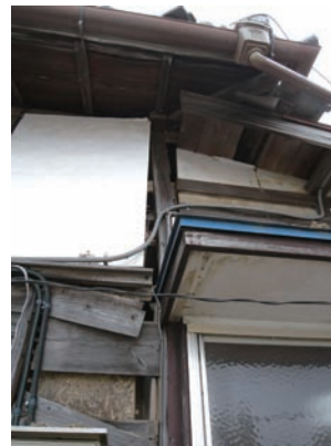
写真 5. 4. 2-8 柱の曲げ変形（台所と居室の境）
