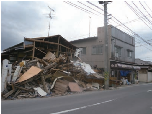
写真 5. 4. 2-45 増築部分が倒壊した隣家
