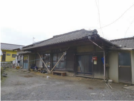
写真 5. 4. 2-5 建物外観－正面
