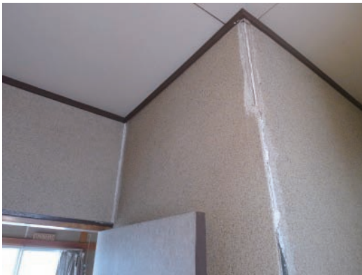
写真 5. 4. 2-25 内壁ラスボードの亀裂
