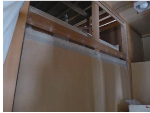
写真 5. 4. 2-14 内壁漆喰ボードの脱落
