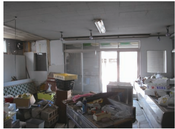
写真 5. 4. 2-32 内部の様子（内装材の落下）
