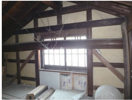
写真 5. 4. 2-40 母屋 2 の 2 階の内観
