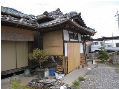
写真 5. 4. 2-7 玄関部の分離、傾斜
