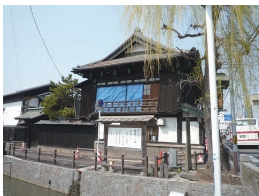
写真 5.4.2-37 母屋3の南側外観
