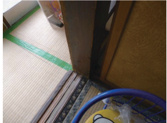
写真 5. 4. 2-6 水平方向に移動した柱脚
