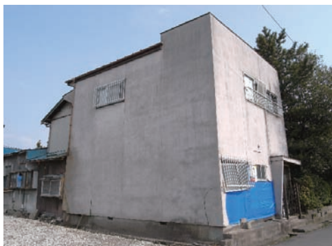
写真 5. 4. 2-29 建物外観（増築部のモルタルの亀裂）
