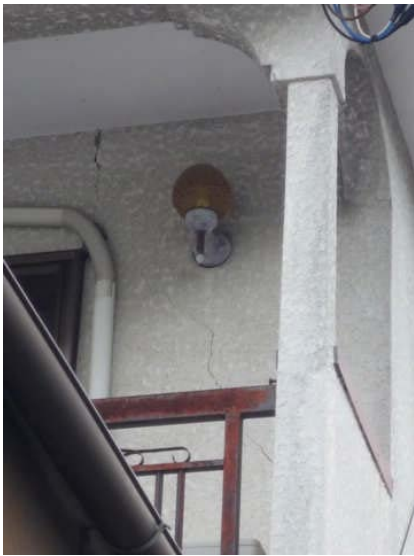
写真 5. 4. 2-53 外壁モルタルの亀裂
