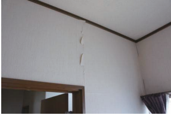
写真 5. 4. 2-13 内壁クロスの切れ
