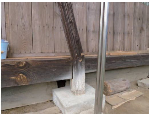
写真 5. 4. 2-17 足固めの高さでの柱の折損
