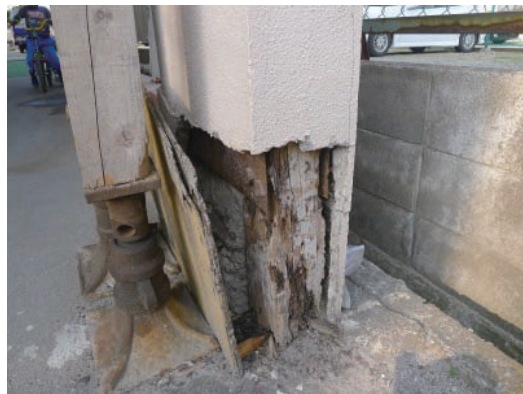
写真 5. 4. 2-24 門型架構 脚部の生物劣化
