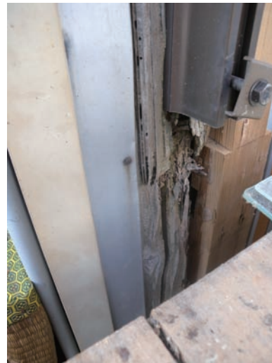
写真 5. 4. 2-46 柱の蟻害と腐朽
