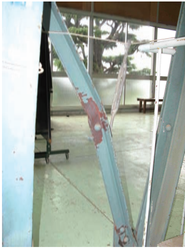
写真 5.3-3 ラチス柱斜材の座屈
