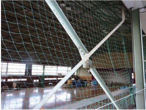
写真 5.3-1 ブレース材の座屈と接合部破断
