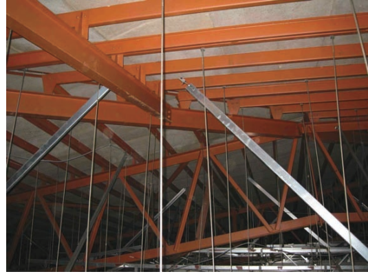
写真 5.3-17 斜め補剛材のはずれ
