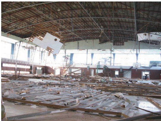
写真 5.3-5 天井、照明の落下
