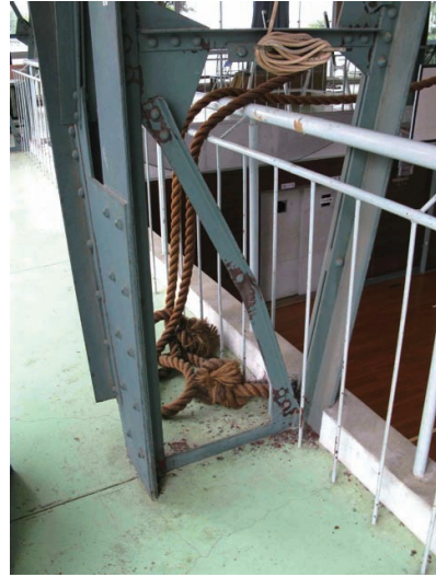
写真 5.3-2 ラチス柱斜材の座屈
