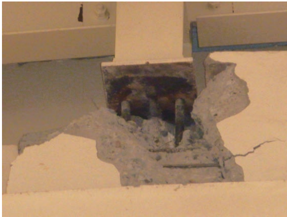
写真 5.3-12 RC 柱と S 造屋根接続部（支承部）のコンクリート剥落、ボルト変形
