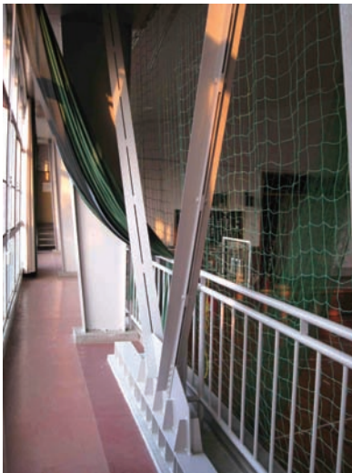
写真 5.3-18 増設した V 型の補強ブレース
