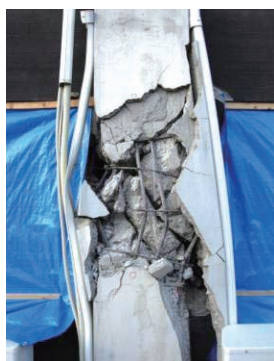
(a) 短柱のせん断破壊
