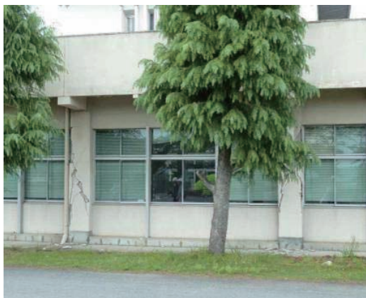
(a) 南側構面柱のせん断破壊
