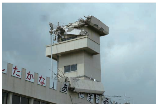
写真 5. 2. 1-4 塔屋の損傷及び落下
