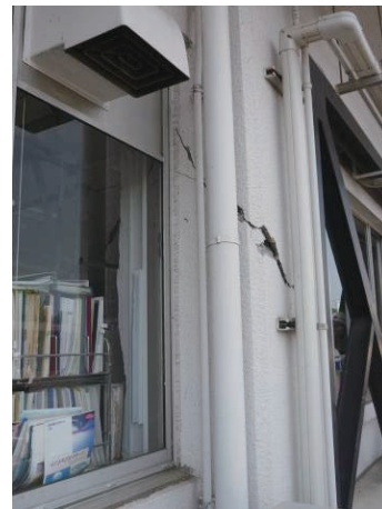
(b) 建築物 J (損傷度 IV)
