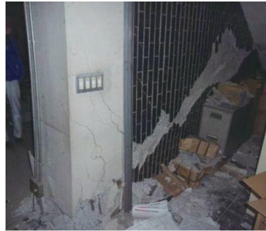
(b) 1階耐力壁のせん断破壊
