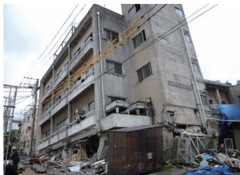
写真 5. 2. 1-1 1階の層崩壊
