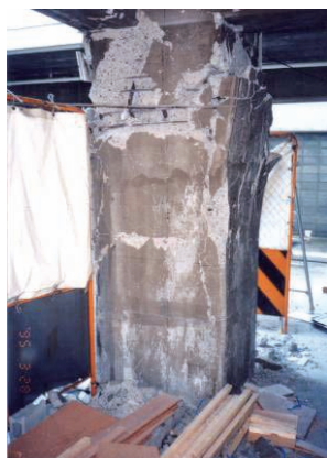
(b) 柱主筋段落とし部の破壊 (表 5.2.1-1 の 4))
