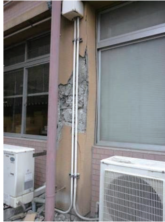
(b) 建築物 F (損傷度 IV)
