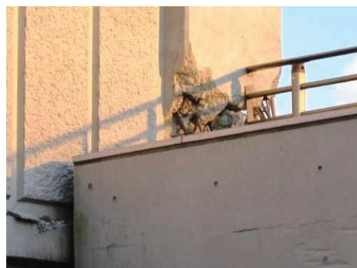
写真 5. 2. 1-6 連層耐力壁側柱脚部の圧壊
