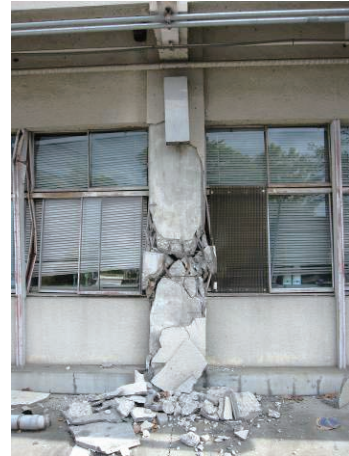
(c) 建築物 I (損傷度 V)
