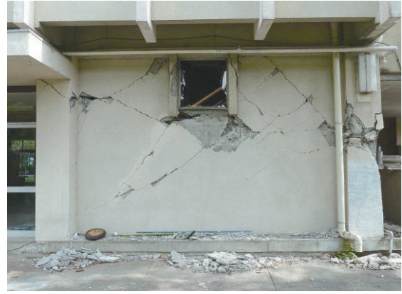
(b) 建築物 I (損傷度 V)
