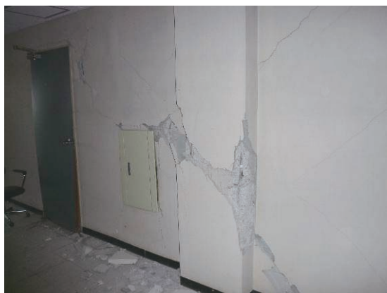
(a) 建築物 C (損傷度 IV)
