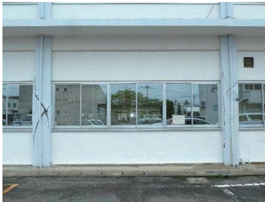
(a) 建築物 H (損傷度 IV)
