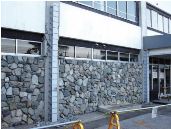
(a) 建築物 A (損傷度 V)
