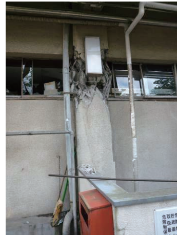
(b) 建築物 I (損傷度 V)
