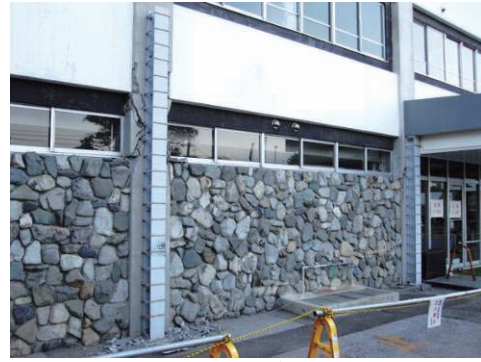
写真 5.2.1-10 応急補強した柱の被害
