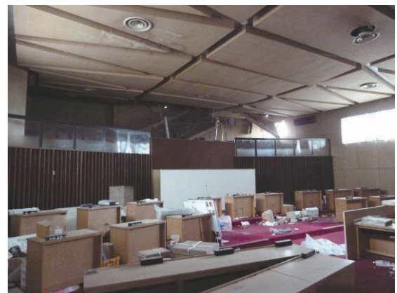
(b) 天井落下 (建築物 I)
