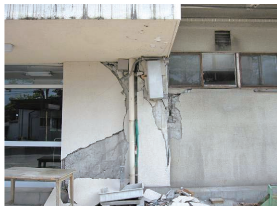
(b) 建築物 I (損傷度 V)
