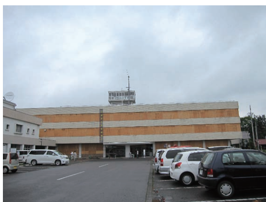
(a) ガラスの落下 (建築物 B)
