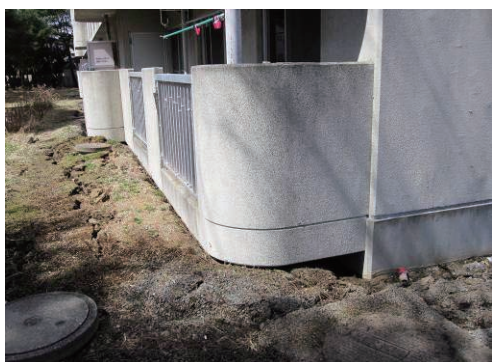
写真 5. 2. 1-3 4階建て建築物の傾斜
