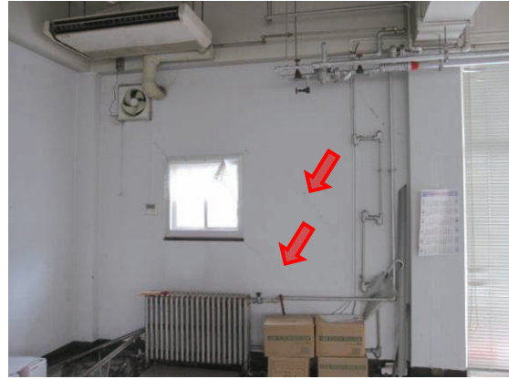
(b) 建築物 G (損傷度 II)
