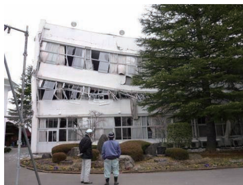
写真 5. 2. 1-2 中間階の層崩壊
