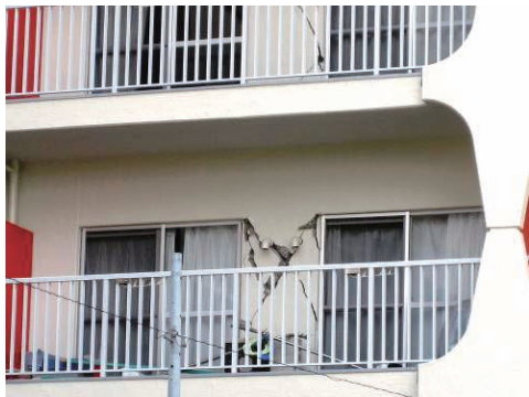
写真 5.2.1-13 非構造壁（ベランダ側）のせん断破壊
