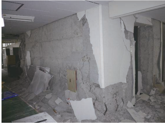
(a) 建築物 C (損傷度 V)
