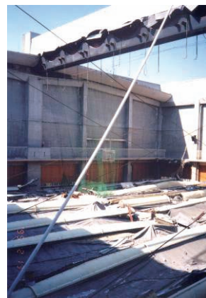
(f) 体育館 PCa 屋根の落下 (表 5.2.1-1 の 22))
