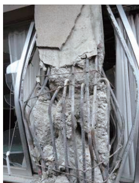
(b) 主筋段落とし部を起点とするせん断破壊
