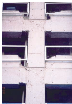
(d) 柱はり接合部の破壊 (表 5.2.1-1 の 10))
