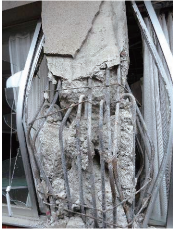
(a) 建築物 C (損傷度 V)
