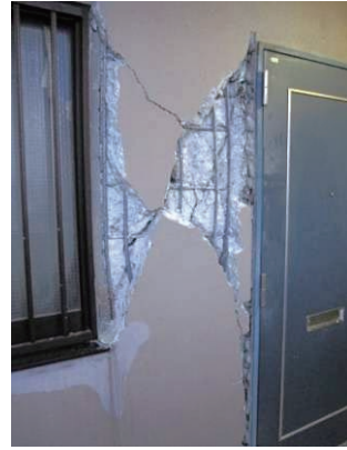
写真 5.2.1-12 非構造壁（玄関側）のせん断破壊
