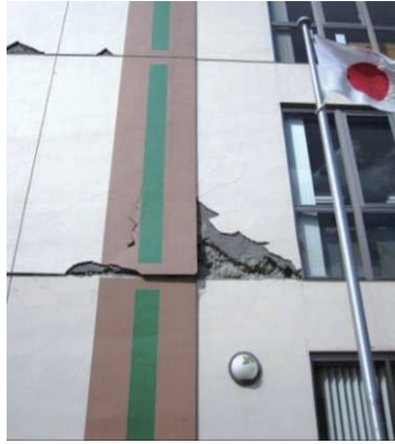
写真 5.2.1-11 袖壁脚部の損傷
