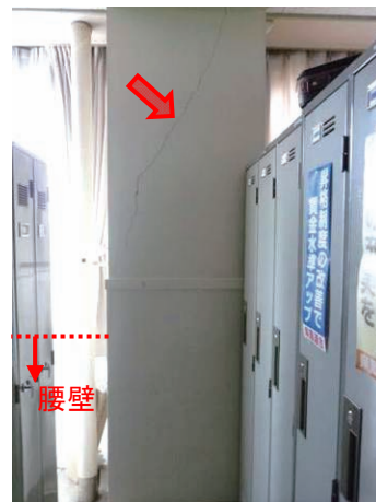
(b) 建築物 E（損傷度 III）
