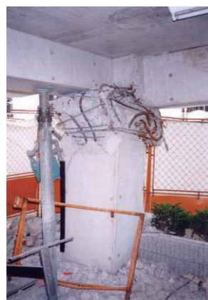
(e) 軸力の大きな柱の破壊 (表 5.2.1-1 の 3))
