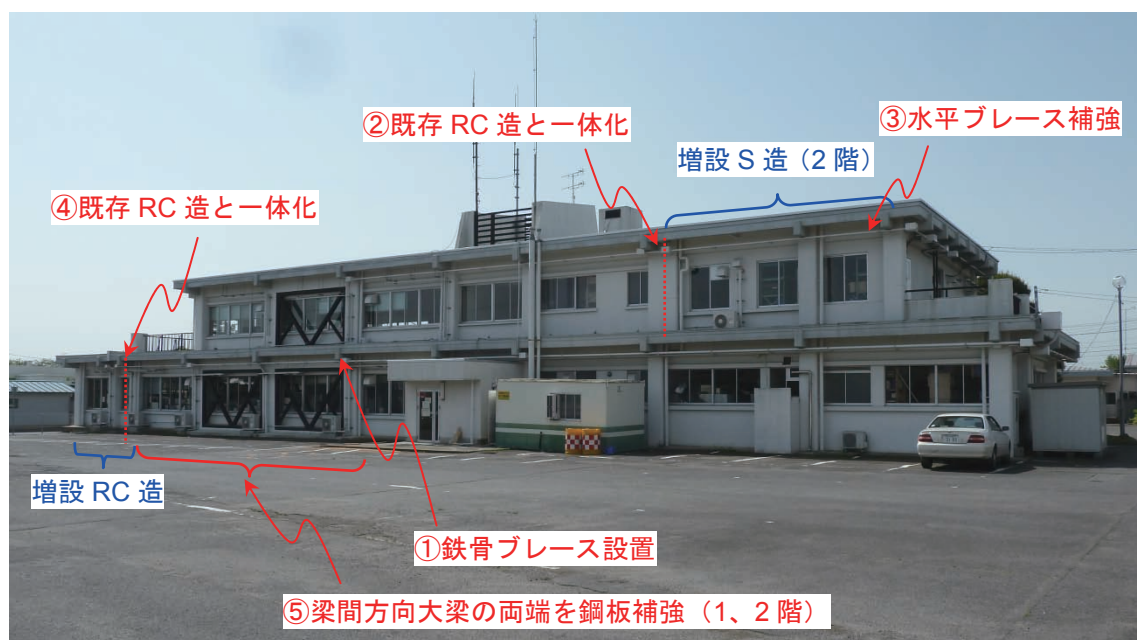
写真 5.2.3.3-1 本建築物外観及び耐震補強概要
