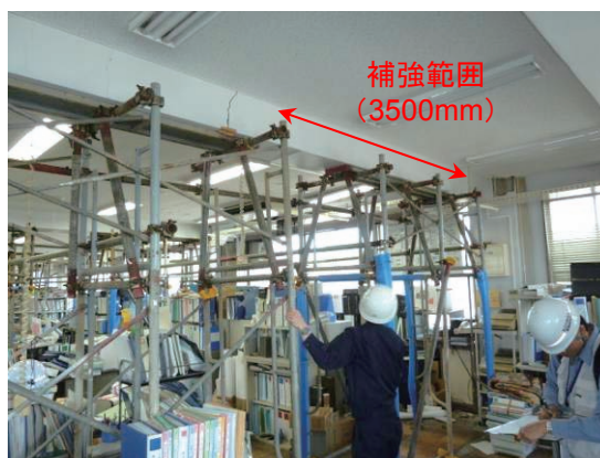
写真 5. 2. 3. 3-2 梁端の鋼板補強
