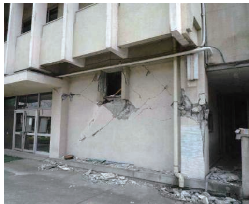
(b) 有開口耐力壁のせん断破壊
