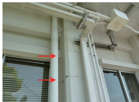
図 5.2.3.3-2 鉛直部材の損傷度調査結果（1 階桁行方向）
