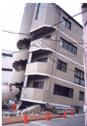
(a) ピロティ階の崩壊 (表 5.2.1-1 の 13))
