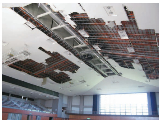
写真 4.3-1 体育館の天井脱落被害
