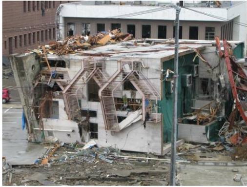
写真 1.4.1 3階建て鉄骨造の転倒
