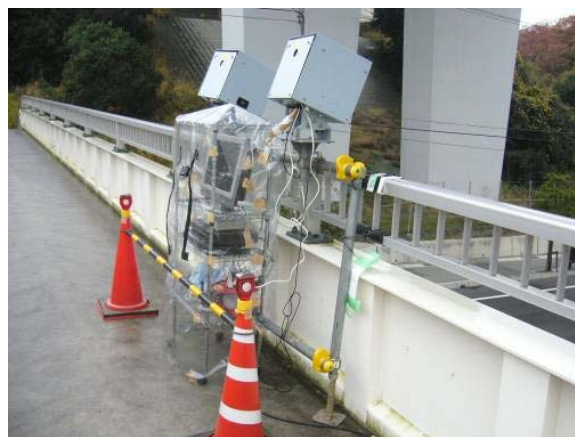
図 3.18 ナンバープレート調査状況
