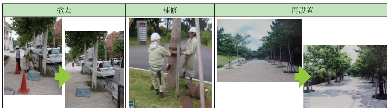
写真 -5.8 支柱の撤去、修復、再設置
