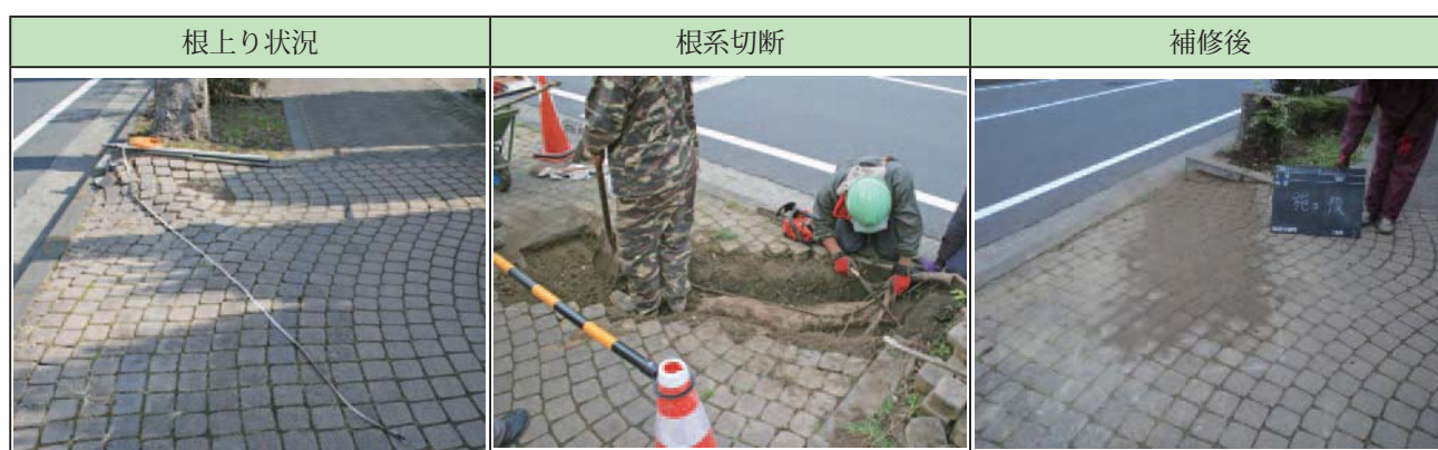
写真 -5.9 根上がりにより盛り上がった舗装の補修
