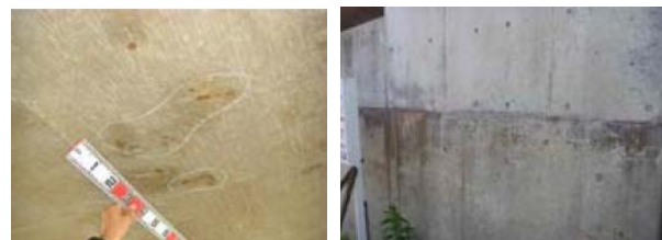
写真-1 錆汁を伴う漏水 (左:斑点状、右:打継目)
