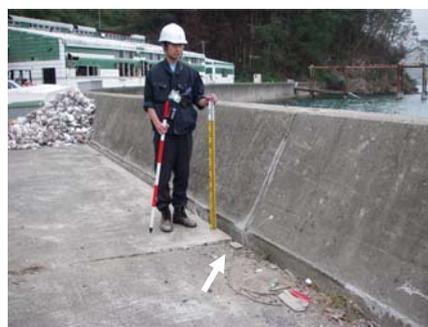
写真-3.4.16 沈下した天端被覆板 (地点 3-m)
