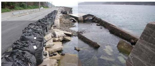
写真-3.4.9 海側に倒壊した護岸(地点3-i)
