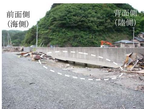
(1) 胸壁の堤体直下の地盤の流出
