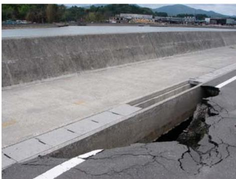
写真-3.3.10 背後側舗装の陥没 (地点2-g)
