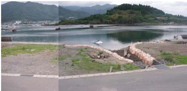
写真-3.2.12 堤防構造の被害 (地点 1-h)
