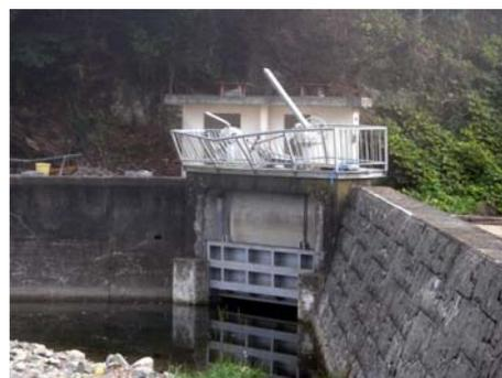
写真-3.4.22 損壊した水門の操作施設 (地点 3-s)
