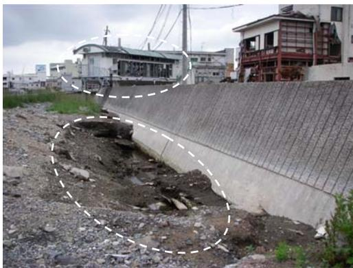
写真-3.2.24 前面側地盤の洗掘と水門の被害 (地点1-o)
