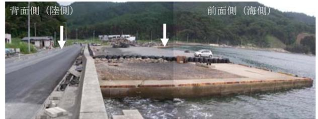
(1) 舗装打直しされた背面側地盤と嵩上げされた物揚場
