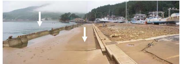
(2) 岸壁の変位と舗装部分の陥没
