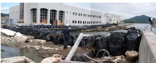
写真-3.3.11 流失した河川護岸 (地点2-h)
