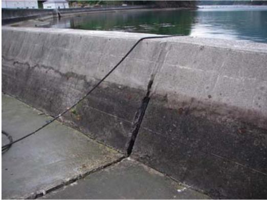
写真-3.2.8 防波堤の目地ずれ (左岸側防波堤)
