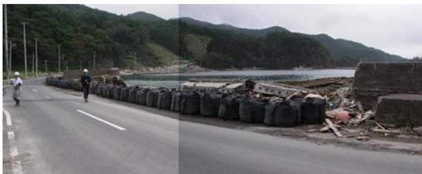
(1) 倒壊した堤防構造の胸壁
