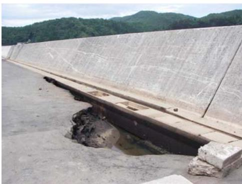
写真-3.3.6 天端被覆工の陥没 (地点 2-d)
