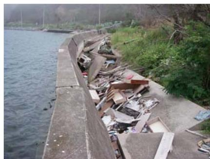
(1) 法線が出入りした堤体と落下・傾斜した天端被覆板
