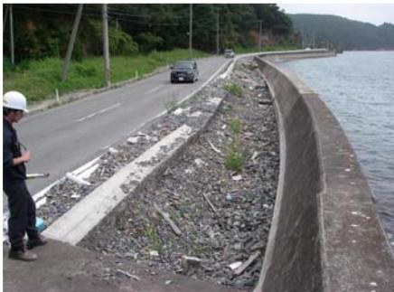
写真-3.4.8 背後側地盤の洗掘(地点3-h)
