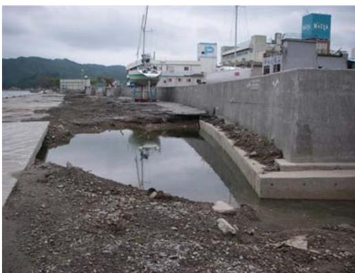
写真-3.2.26 前面側地盤の洗掘 (地点1-q)
