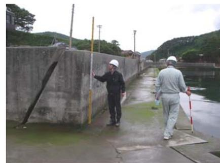
写真-3.2.7 堤体のすり合わせ部の開き (地点1-f)
