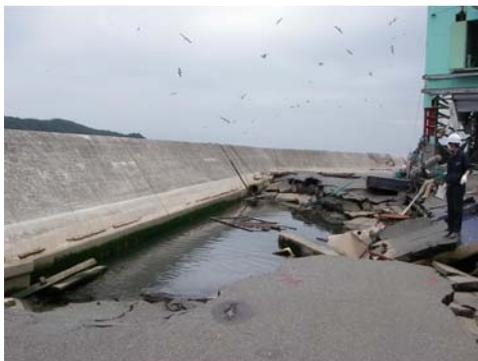
写真-3.3.7 天端被覆工の陥没 (地点2-e)
