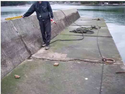
写真-3.2.9 防波堤の目地ずれ (左岸側防波堤)
