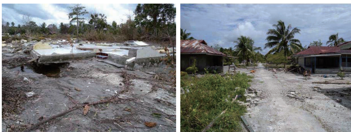
図 I-4-10 津波による被害状況
