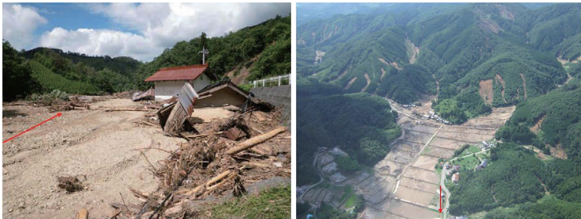
図 I-4-6 土石流による被害状況
