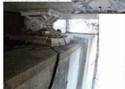
橋脚天端付近の損傷
