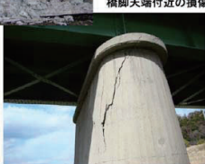
橋脚天端付近の損傷
