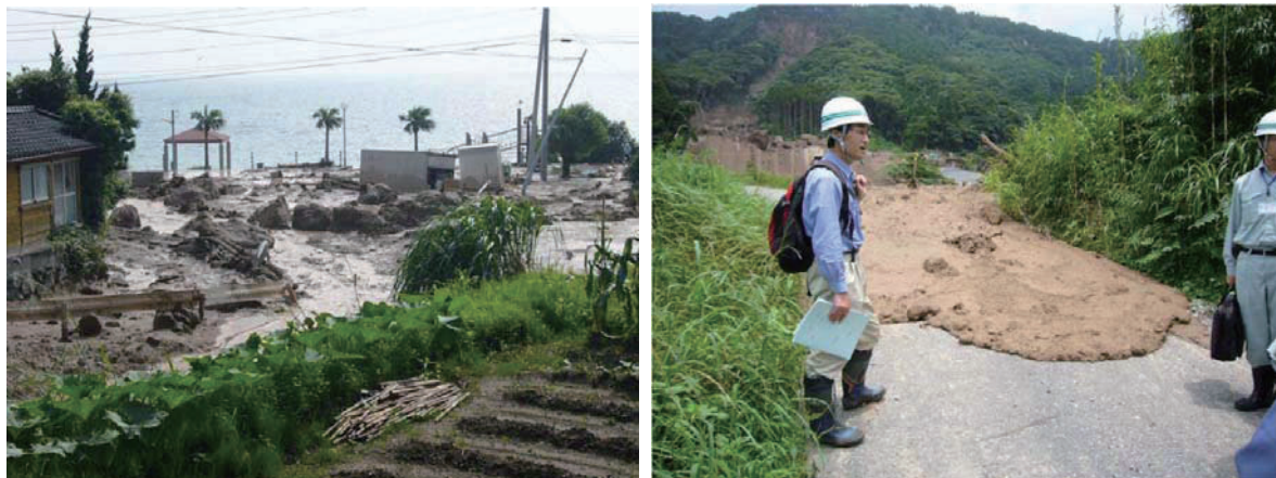
図 I-4-9 土石流による被害状況
