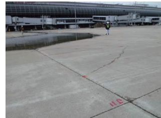
写真-3 エプロンに発生した沈下とクラック(3スポットをクローズ)
