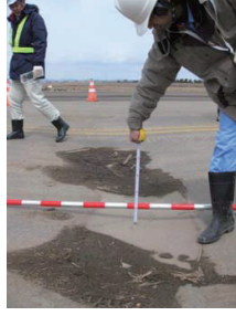
写真-2 誘導路に発生した沈下
