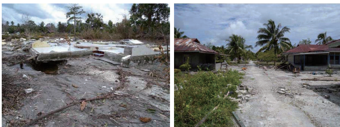
図 I-4-10 津波による被害状況
