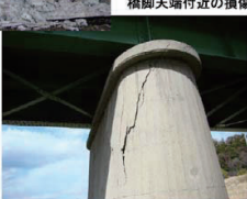
橋脚天端付近の損傷
