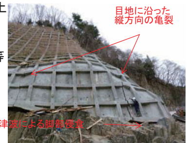
目地に沿った縦方向の亀裂 津波による脚部侵食 宮城県女川町川尻地区の現地調査
