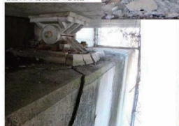
橋脚天端付近の損傷
