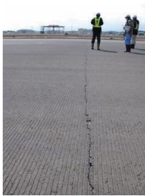
写真-1 滑走路のクラック(誘導路と合わせて22本発生)
