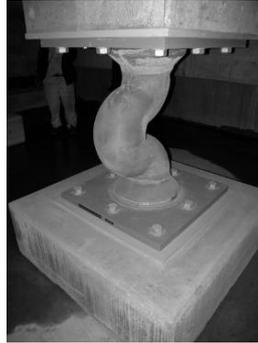
写真 21 免震建築物の鉛ダンパーに発生した亀裂
