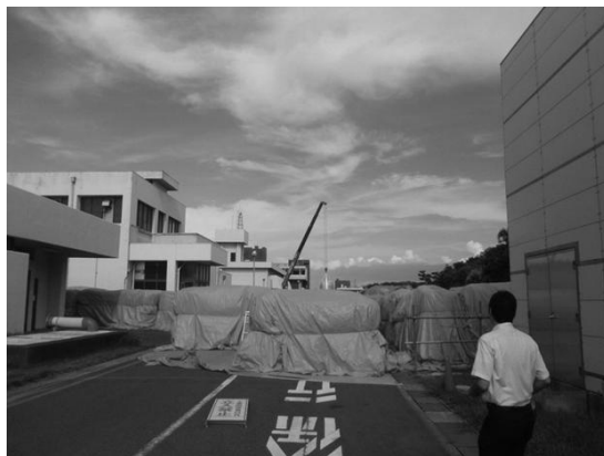
写真-8 下水処理場内（場内道路に仮置き）における脱水汚泥一時保管の様子
