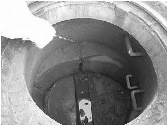
写真-4 マンホールの駆体ズレ（浦安市） 写真-5 管きよの浮き上がり（潮来市）
