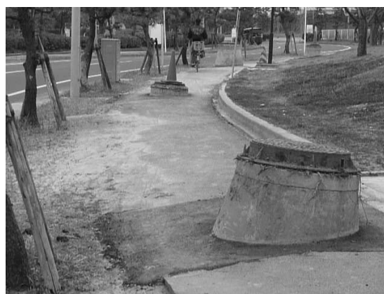
写真-3 マンホールの浮上(浦安市)
