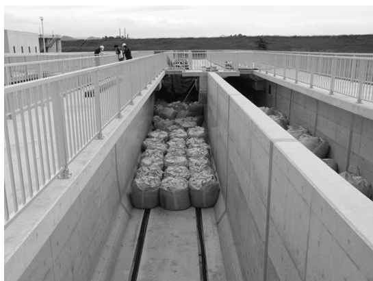
写真-7 下水処理場内（水路内に仮置き）における脱水汚泥一時保管の様子
