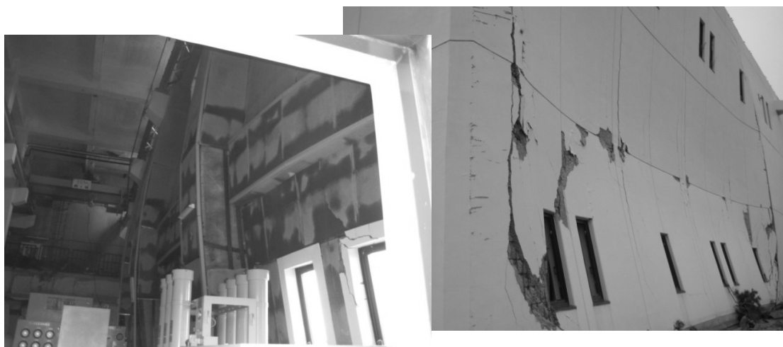
写真-2 津波による建物壁面の変形（南蒲生浄化センター）
