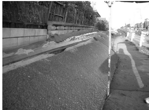
写真-4 マンホールの駆体ズレ（浦安市） 写真-5 管きよの浮き上がり（潮来市）
