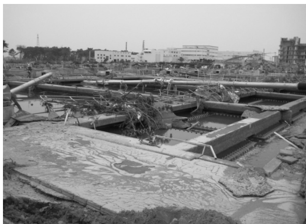
写真-1 水処理へのガレキ侵入と設備破損（南蒲生浄化センター）
