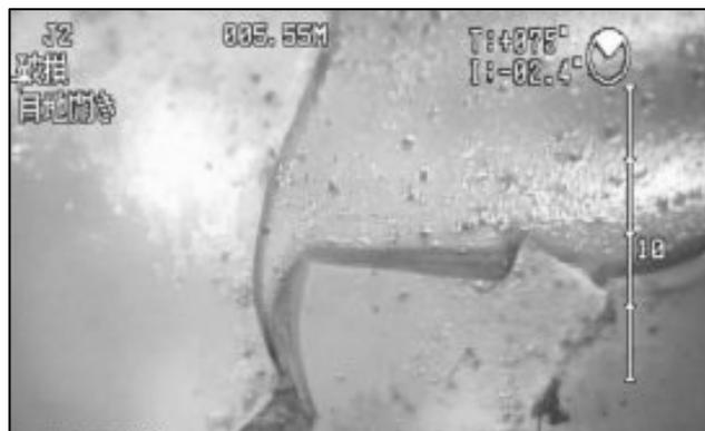
写真-2 破損した塩化ビニル管
