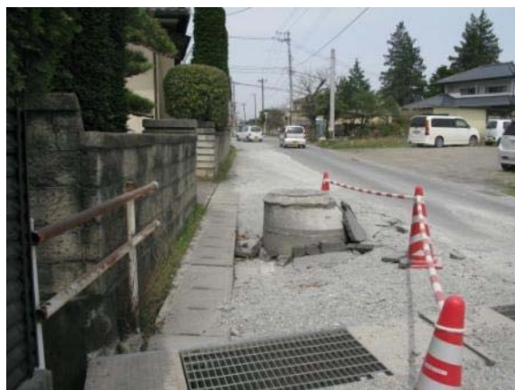
(b) マンホールの浮上
