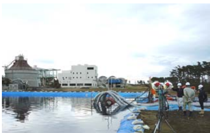
写真-8.8 宮城県県南浄化センター簡易処理放流状況の確認
