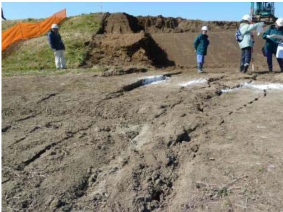
図-2.5 河川堤防の亀裂（小貝川）
