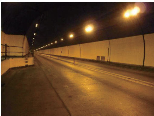
トンネル坑内及び路面の状況
