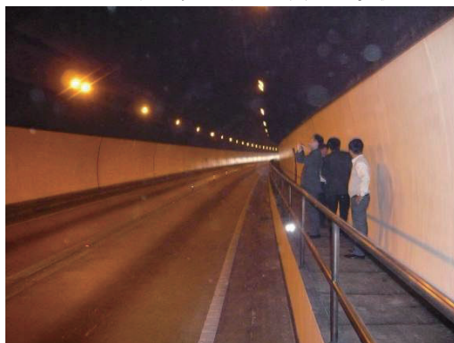
トンネル坑内壁面調査状況
