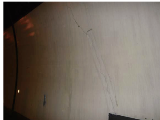
確認されたひび割れの一例
