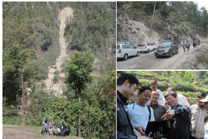
写真5 現地調査の様子（NH31A道路 地すべり災害地）
