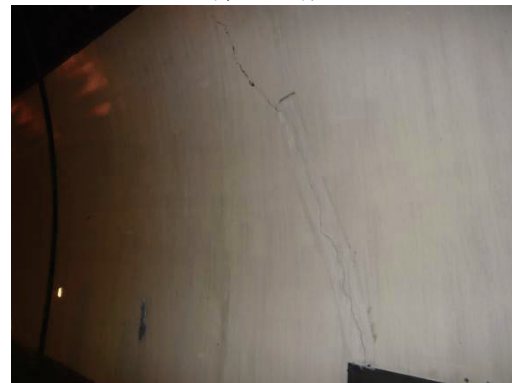
確認されたひび割れの一例
