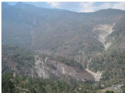
写真 8 現地調査の対象地② (Manjin 地区被災地)
