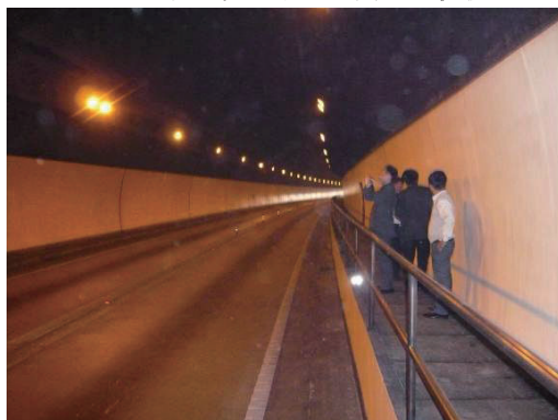
トンネル坑内壁面調査状況
