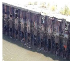
老朽化した護岸の例
