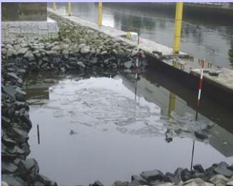
潮溜まりの大きさは、10m x 4mで深さが約50cmです。小さな切欠きを作って海水の浸入が容易になるように工夫されています。
