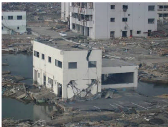
写真1 建築物の外観
