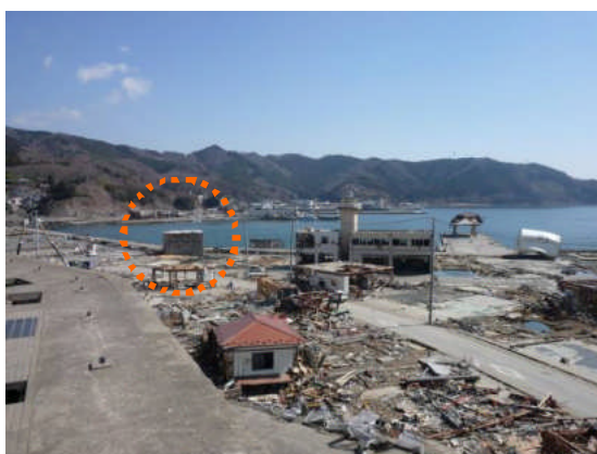
写真 1 転倒建物（丸印、海側に転倒）
