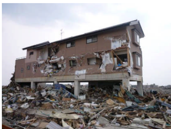
写真3 漂流物の衝突による被害
