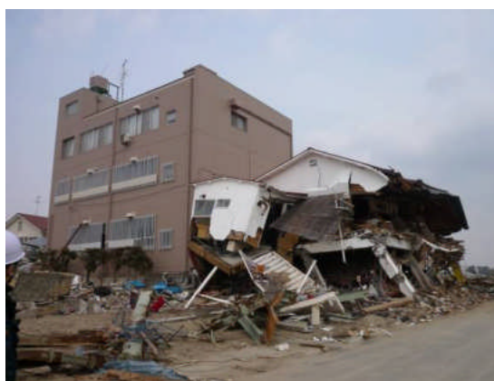
写真2 隣の建物が倒れ掛かっている
