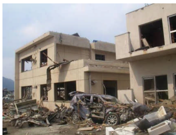
(南東から見る)
