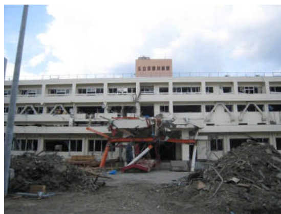
写真4 病院外観（耐震補強済み）
