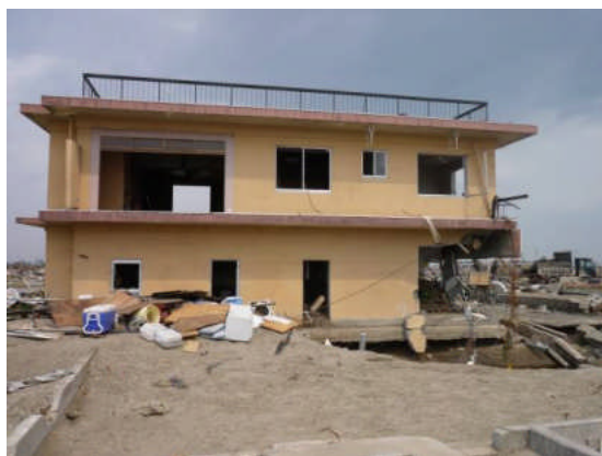
写真 1 RC 造壁式建物
