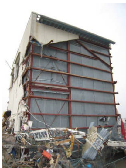
写真3 外壁が流失
