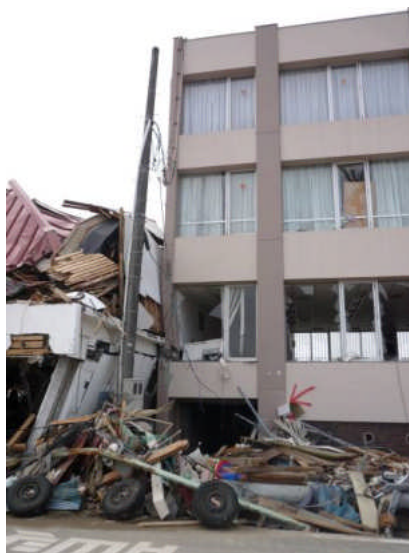
写真4 妻壁の損傷
