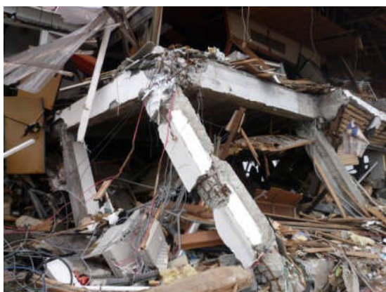
写真3 1階 RC 造架構
