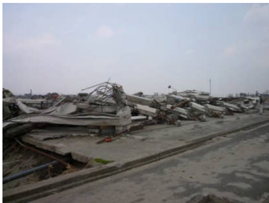
写真 1 倒壊した建物
