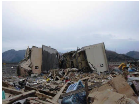
写真2 転倒した集合住宅棟
