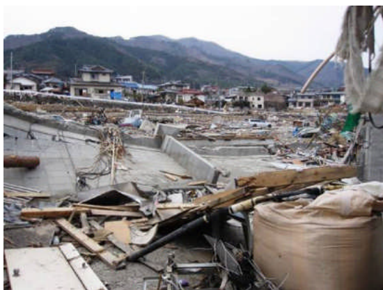
写真3 転倒したコンクリートブロック壁(1)
