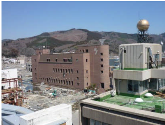
写真 1 I 号館全景
