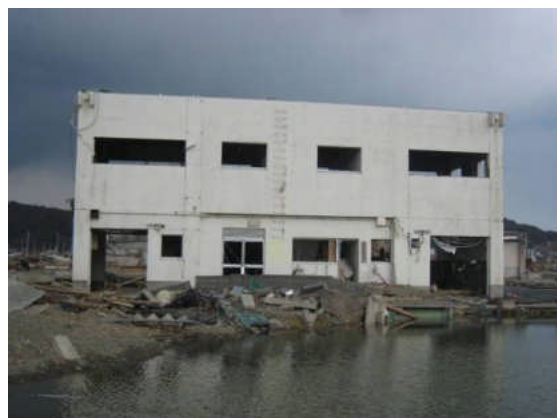
写真2 建築物の外観
