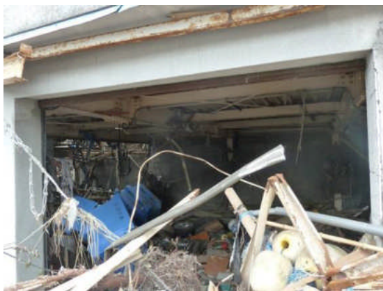
写真3 内部のコンクリートブロック壁
