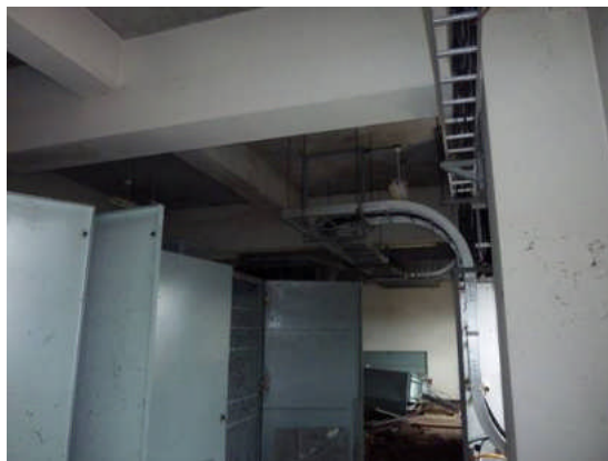
写真 4 2 階床を有する棟の内部
