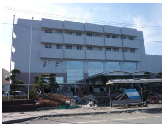
写真 4 建物（東面、港側）
