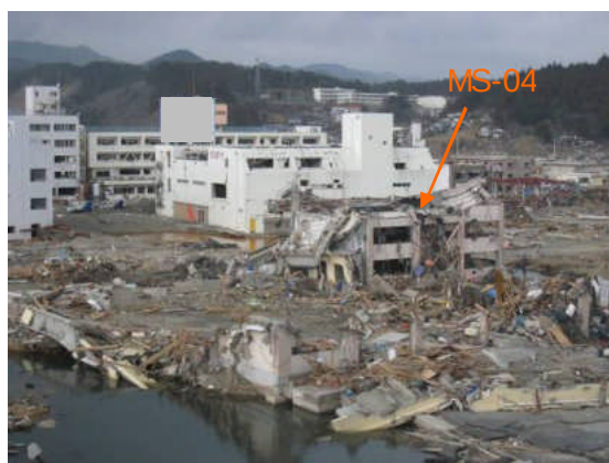
写真1 建築物の遠景（海側から）
