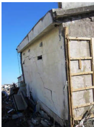
写真 3 コンクリートブロック壁
