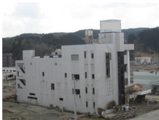
写真2 建築物外観（東面）
