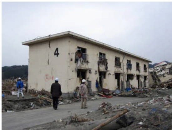
写真1 残存した集合住宅棟
