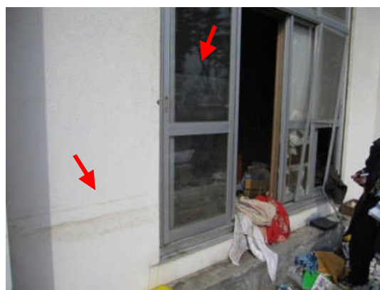
写真2 1階の浸水痕
