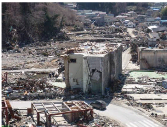
写真 1 建物の遠景 (北東側から)
