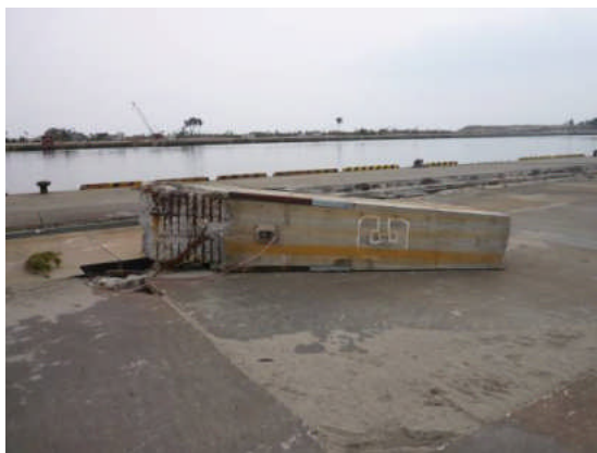
写真3 独立柱 (1本だけ残存、他は流失)
