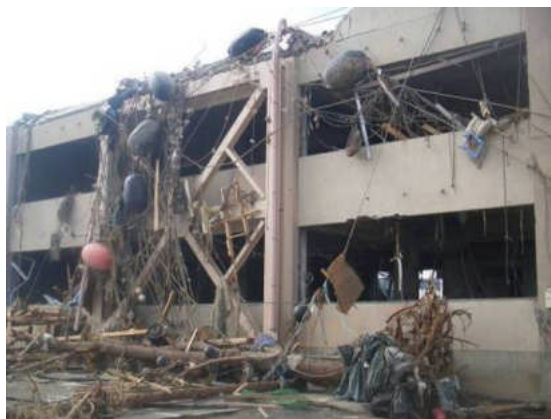
写真3 建築物外観（東面）
