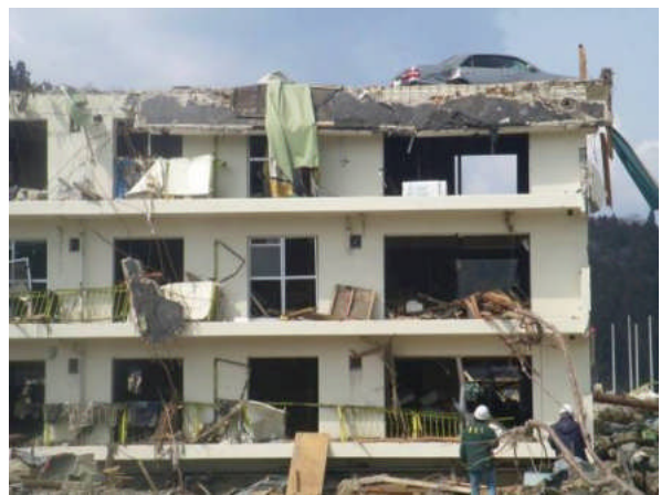
写真2 開口部の損壊と屋根に残存した乗用車
