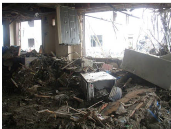
写真 2 1 階内部の状況
