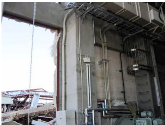
写真3 架構内部の RC 耐震壁
