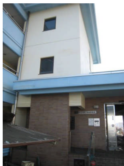
写真 2 エントランス部
