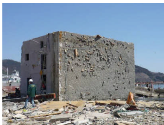
写真 2 建物底面（直接基礎）
