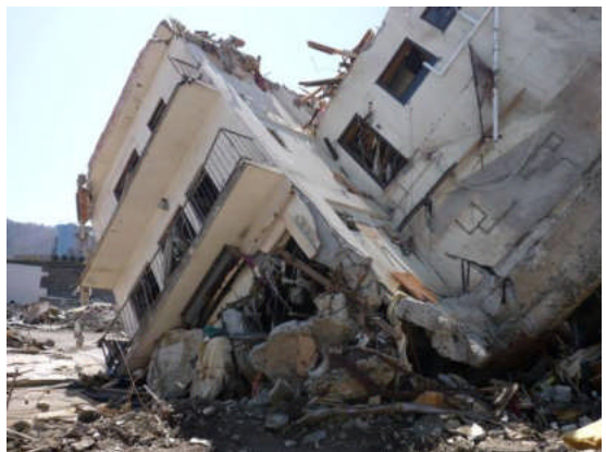
写真4 隣で転倒した建物
