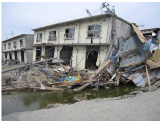
写真1 周辺地盤の洗掘による建物傾斜
