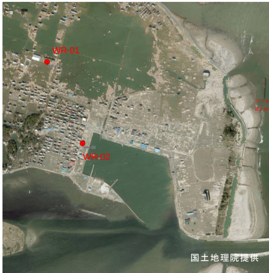
亶理町荒浜地区建物調査位置
