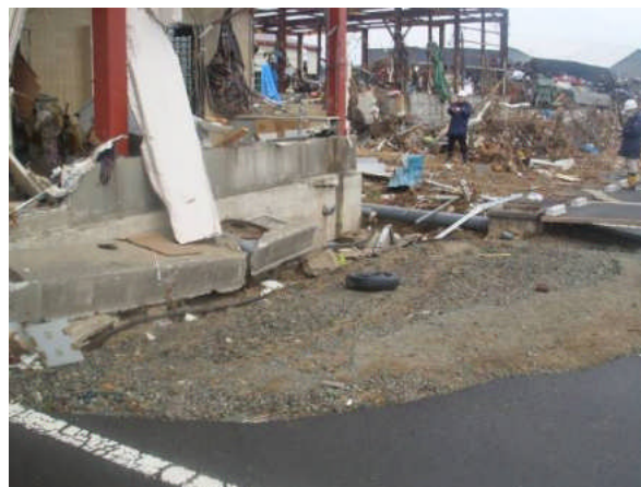
写真4 地盤の洗掘
