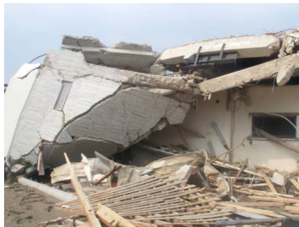
写真 3 耐力壁の倒壊
