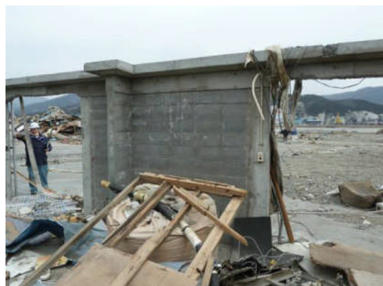
写真4 ブロック壁を挟むRC柱
