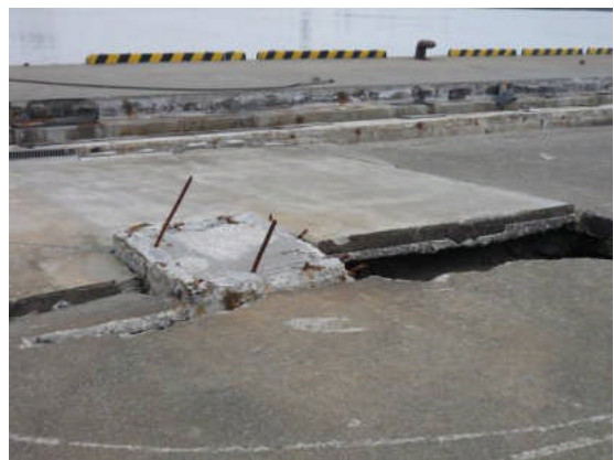
写真3 独立柱 (1本だけ残存、他は流失)
