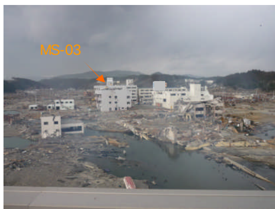
写真1 建築物の遠景（海側から）
