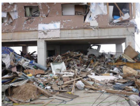
写真4 1階RC造架構は無被害
