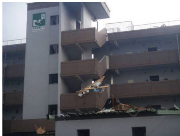
写真2 建築物の外観
