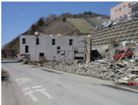
写真1 移動・転倒した建物
