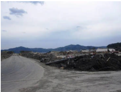
写真 14 破壊された近所の防潮堤
