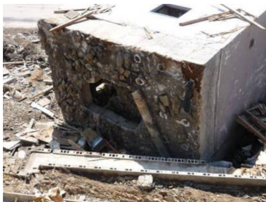
写真2 基礎底面（杭の破断） 基礎スラブ厚 500mm
