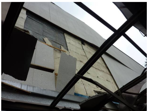
写真 5. 6-63 外装板とラスモルタル外壁の被害
