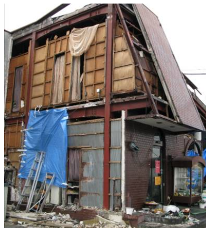
写真 5. 6-6 (左) 写真 5. 6-7 (右) ALC パネルの脱落被害
