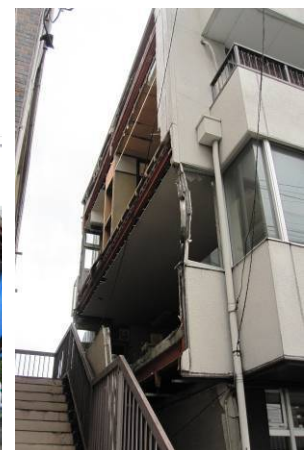
写真 5. 6-6 (左) 写真 5. 6-7 (右) ALC パネルの脱落被害
