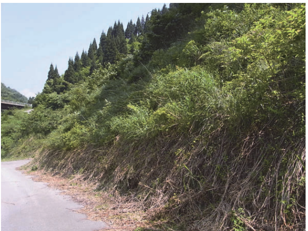
写真-3 滋賀県の調査地（調査地番号 12）
