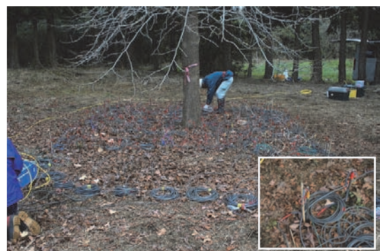
写真-1 比抵抗探査法における電極設置 実験対象樹木は以下のとおりである(写真-2)。
