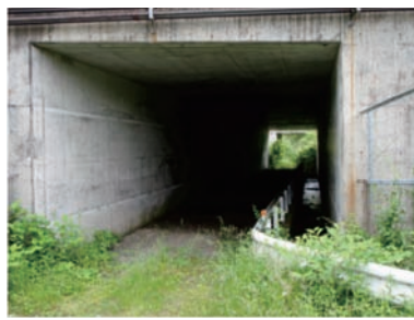
BC: 盛土部においてコンクリート製ボックスを設置し道路下を移動させるアンダーパス(東富士五湖道路)
