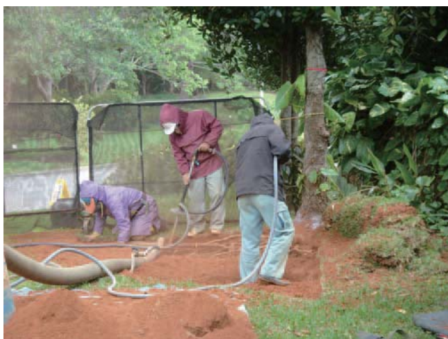
写真-2.2 水平方向の土壌掘削
